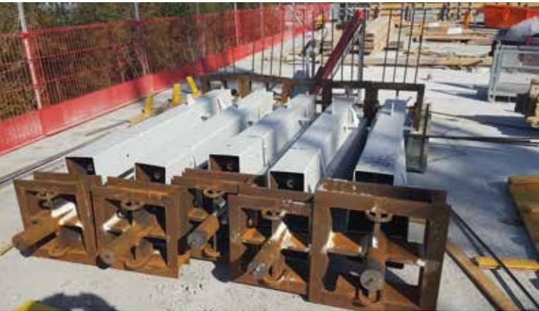
Die Bauprojekte werden von Anfang an vom Hersteller begleitet. Hier sieht man Verbundstützen kombiniert mit Stahlpilz in der Bauphase.
