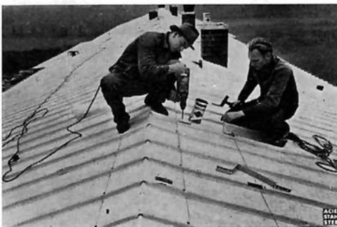
Bild 9: Eindecken von Wohnbauten mit verzinkten Stahldachpfannen
