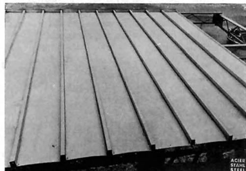
lange wall elements made of sheet steel and enamelled profilierten, verzinkten Stahlblechen
