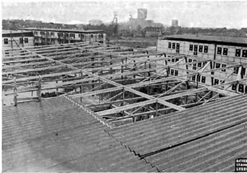
Bild 8: Verlegung von kunststoffbeschichtetem Wellblech als Dachhaut für die Pultdächer von dreigeschossigen Wohnhäusern. Die einzelnen Tafeln werden mit Kitt- raupen gegen das Eindringen von Wind, Wasser und Schnee abgedichtet
