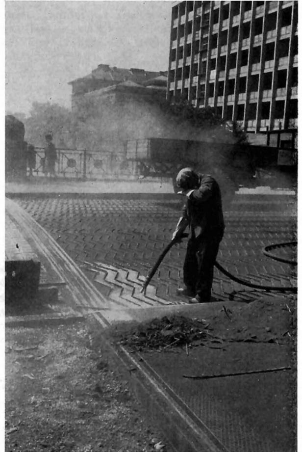
Bild 4: Entrosten mittels Sandstrahlung
