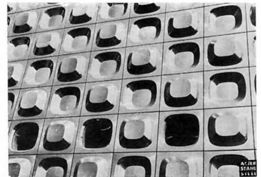
Bild 31: Schalenelemente aus nichtrostendem Stahlblech für die Außenwand eines Ausstellungsbauwerkes
