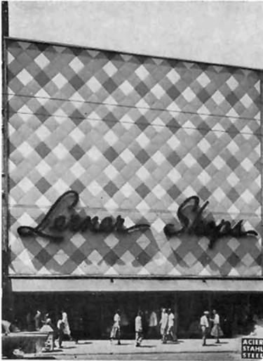
Bild 33: Verblendung eines Kaufhauses mit Wandtafeln aus farbig emailliertem Stahlblech
