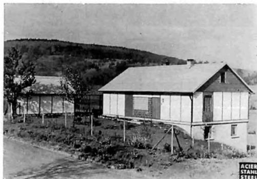
Bild 55: Stahlfertighaus und Fertiggarage mit großflächigen Wandelementen aus weiß und farbig emailliertem Stahlblech
