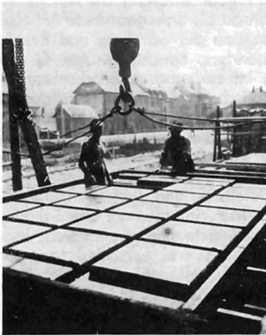
Bild 11: Verschiebbare Kassetten zur Herstellung beliebiger Wandplatten
