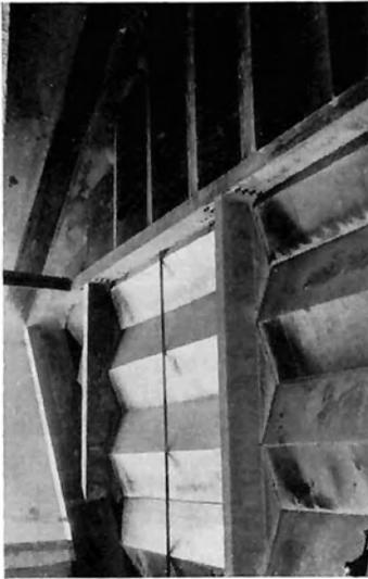
Bild 4: Ausschnitt einer Längswand mit Längsträgern und Stützen
