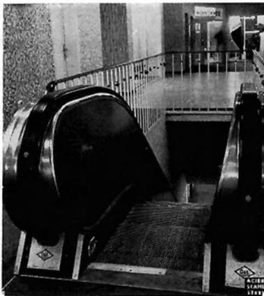
Bild 39: Rolltreppenverkleidung aus kunststoffbeschichtetem Stahlblech
