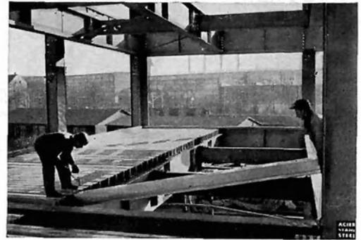
Bild 11: Verlegung einer Stahlzellendecke in einem Stahlskelettbau
