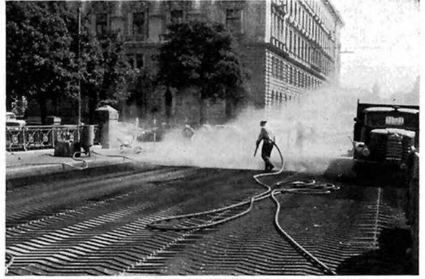
Bild 5: Entrosten mittels Sandstrahlung
