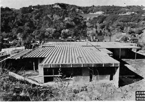
Bild 57: Hochstegiges flaches Stehfalzdach für ein eingeschossiges Einfamilienhaus
