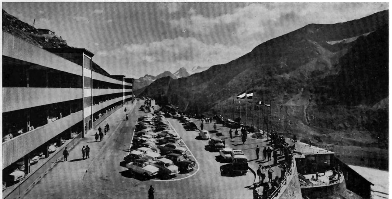
Geschoßparkplatz Freiwandek (Großglockner-Hochalpenstraße) mit einem Gesamtfassungsraum für 900 Personenkraftwagen
