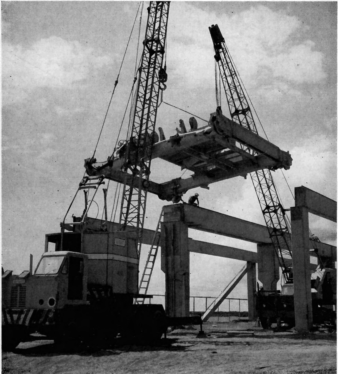
Montagephase einer Anlage im Hafen von San Félix am Orinoco.
