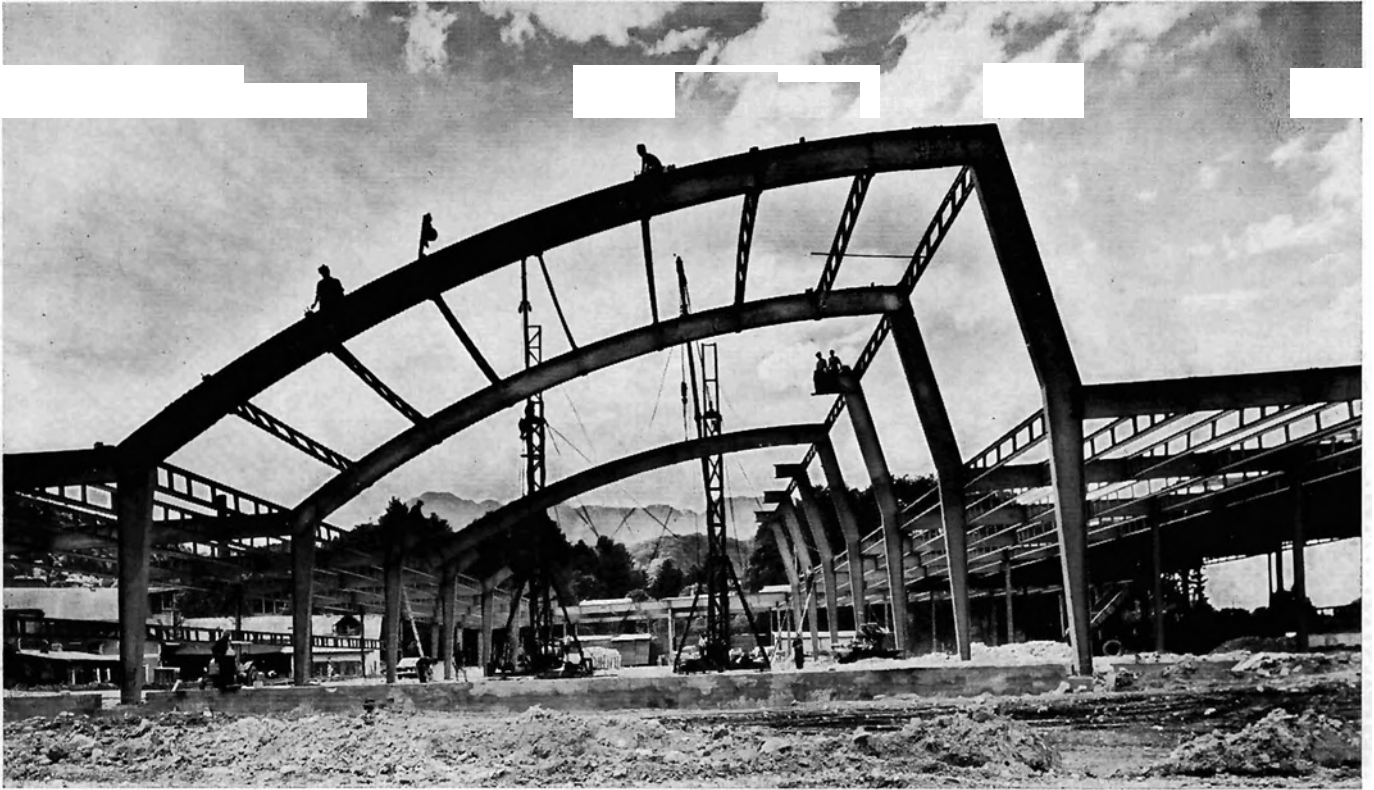
GESCHWEISSTE HALLENKONSTRUKTIONEN FÜR EINE PAPIERFABRIK IN ÖSTERREICH
