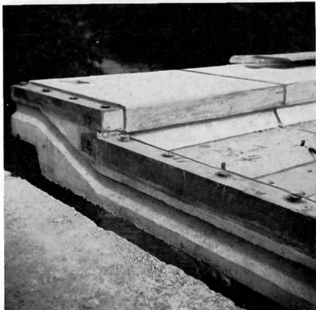
Bild 10: Die Endplatte mit dem Anschlußstück für den Fahrbahnübergang (Schleppplatte). In diesem Bild ist auch der Obergurt des Stahlträgers mit dem 2 cm dicken Mörtelbett erkennbar
