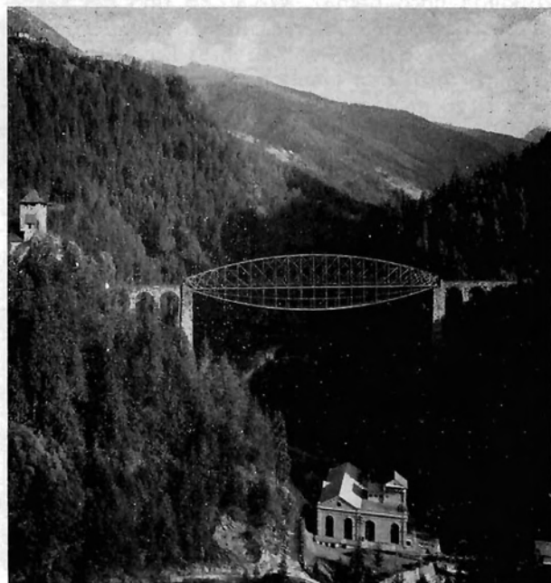
Bild 1: Trisannabrücke mit dem alten Schweißeisenträgerwerk
