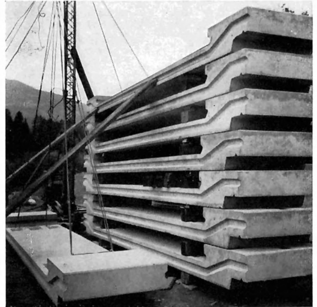
Bild 3: Das Lager der vorgefertigten, schlaff bewehrten Stahlbetonplatten, welche während der Montage des Stahltragwerkes von Graz antransportiert wurden
