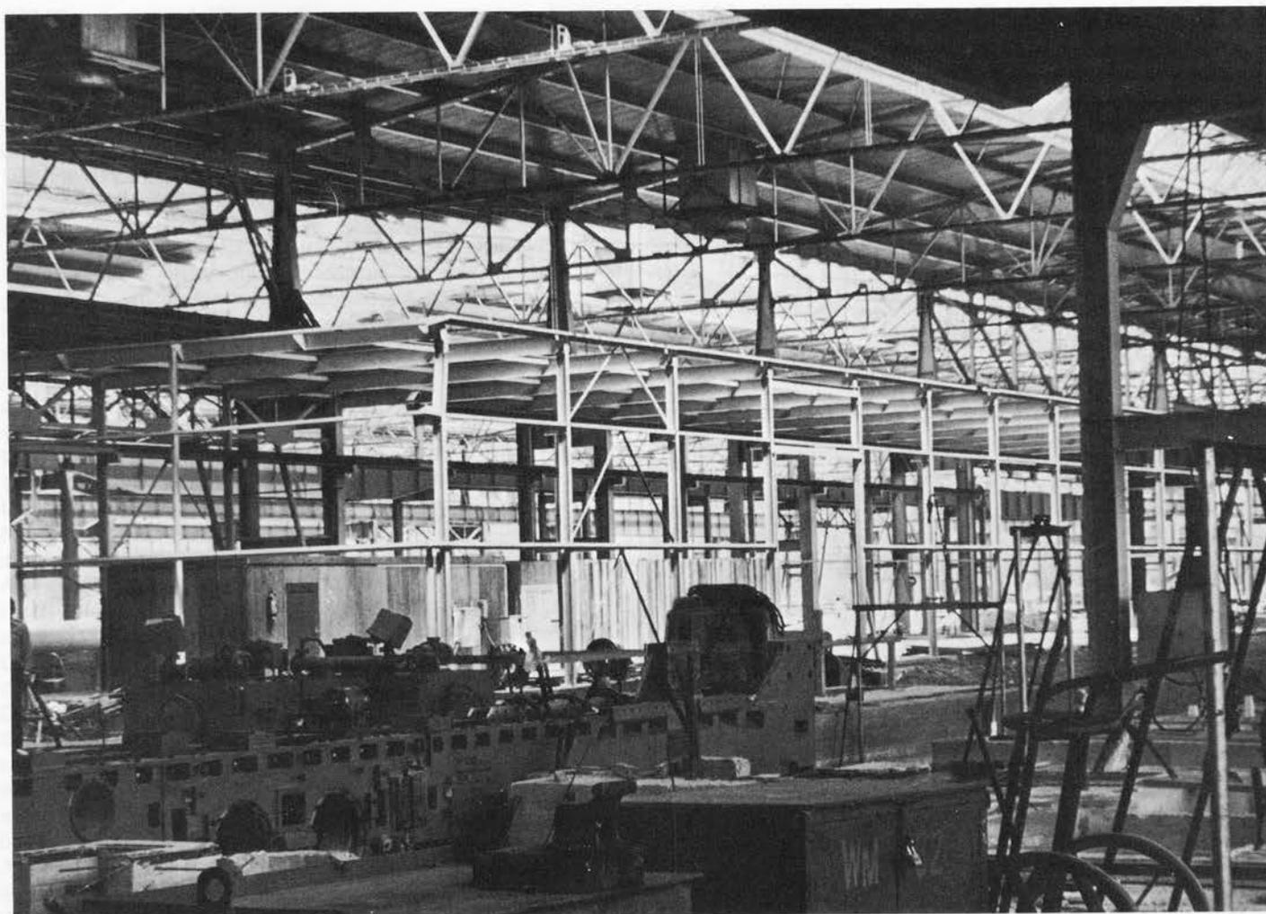
mit oberem und unterem Horizontalverband oder als Vollkastenquerschnitt aus Blech ausgebildet und lagern über Kippleisten auf den Stützen auf. Die Kranschiene sind mittels Klemmplättchen auf den Trägern befestigt. Die Kranbahn- bzw. Hallenstützen sind durchwegs als Rahmenstützen ausgebildet. Die Stützen der Reihen A, C, E und A1 übernehmen neben allen Vertikallasten und den Horizontallasten der Krane auch jene aus der Windbelastung quer zu den Hallenachsen.
