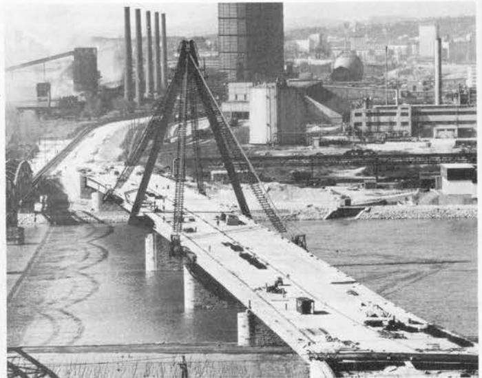
Ø 69 mm. Das sind die gleichen Seile, wie sie bei der VOEST-Brücke verwendet wurden, mit einem mehrlagigen Runddrahtkern und drei Z-Drahtlagen, von denen die äußerste feuerverzinkt ist. Ihre Bruchlast beträgt 500 t, die zulässige Seilkraft 207 t, das heißt, ein Seilbündel wird bei Kombination aller Lastfälle mit 3100 t belastet.
