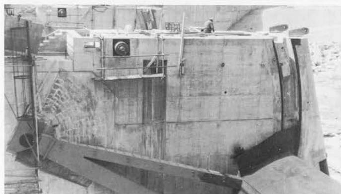
Wehr 1 – Seitendichtung und Segmentlagerung.
