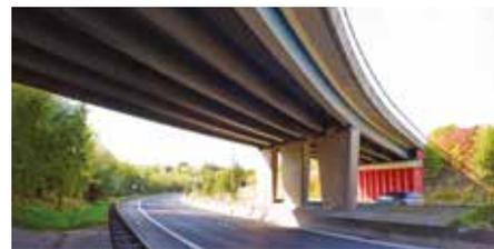
Durch Verwendung von Walzprofilen und Spundwänden bei Brückenbauwerken werden Bauzeiten reduziert und Staus vermieden.
