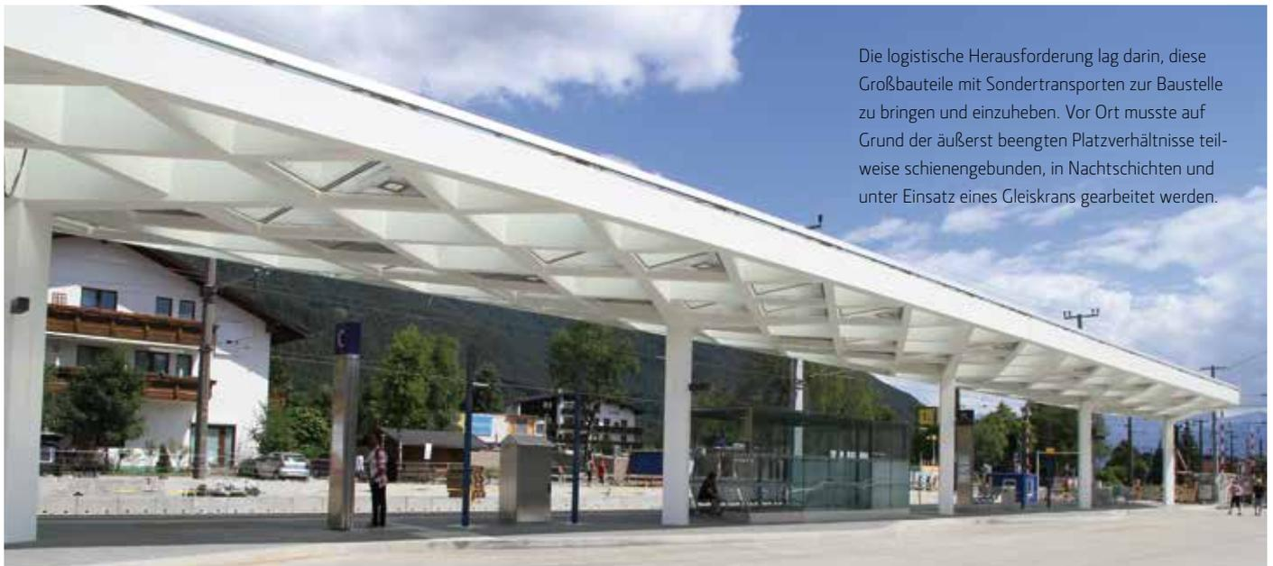
Die logistische Herausforderung lag darin, diese Großbauteile mit Sondertransporten zur Baustelle zu bringen und einzuheben. Vor Ort musste auf Grund der äußerst beengten Platzverhältnisse teilweise schienengebunden, in Nachtschichten und unter Einsatz eines Gleiskrans gearbeitet werden.
