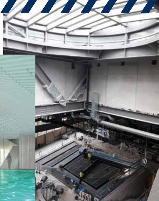
Beim neuen Paracelsusbad in Salzburg verschwinden die hochkomplizierten Stahlkonstruktionen hinter einer eleganten Decke im Badbereich.
