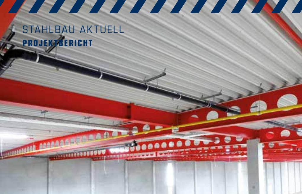
Mit Lochstegträgern werden Tragwerke leichter und Spannweiten größer. Der Effekt: größere Flexibilität in der Nutzung, ergänzt durch eine hohe Funktionalität mit der Möglichkeit, technische Installationen (Rohre, Leitungen) durch die Öffnungen zu führen.
