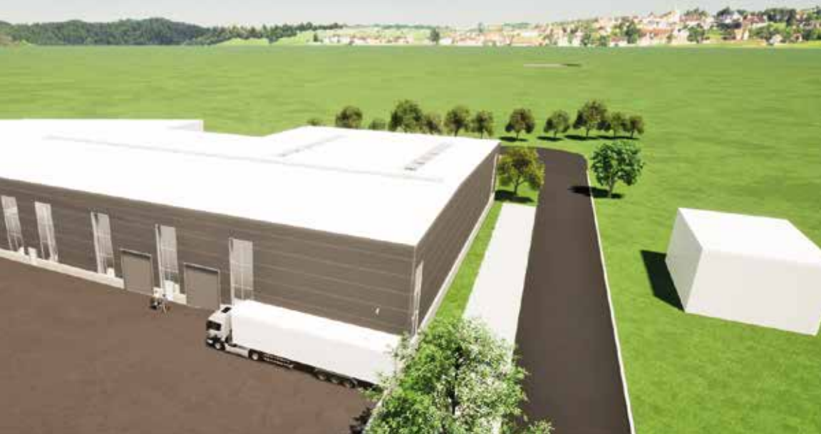
Die neue Halle in Stahlkonstruktion wird nahezu zwischenstützenfrei errichtet.
