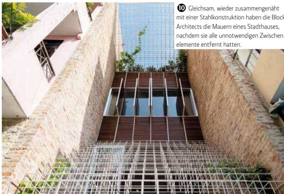
**10** Gleichsam, wieder zusammengenäh mit einer Stahlkonstruktion haben die Block Architects die Mauern eines Stadthauses, nachdem sie alle unnötigen Zwischenelemente entfernt hatten.
