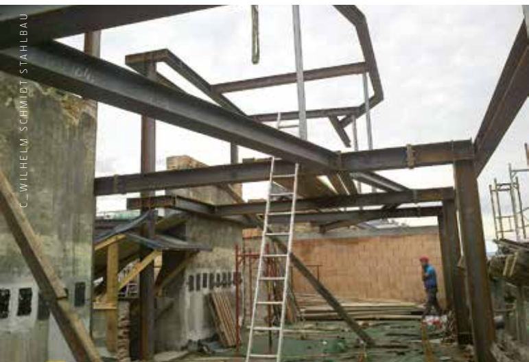
Wenn alle Bedingungen optimal sind, dann können innerhalb von zwei Wochen 30 bis 40 Tonnen Stahlbau für die Aufstockung auf das Gebäude aufgebracht werden.
