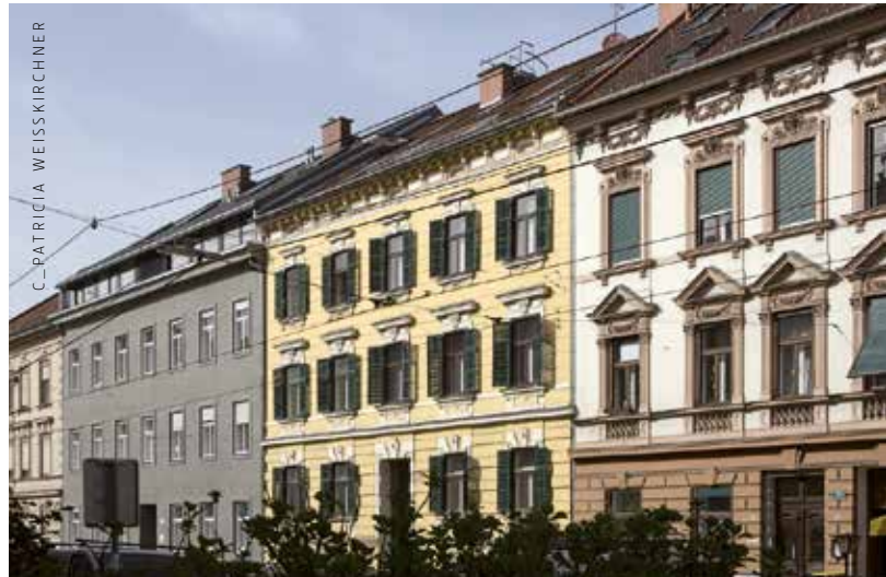
In Graz bleiben laut „Pro Steildach“ viele Dachböden ungenutzt. Im grauen Haus erfolgte ein privater Dachgeschoßausbau in der Innenstadt von Graz.
