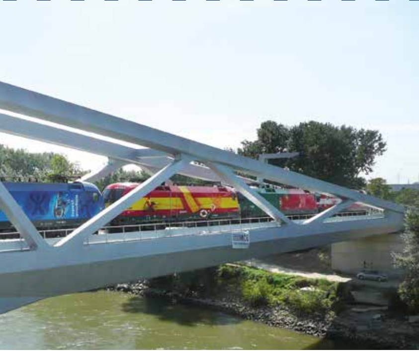
Die Winterhafenbrücke in der Freudenau überspannt die Donau. Sie zeugt von den architektonischen Leistungen im Stahlbau.
