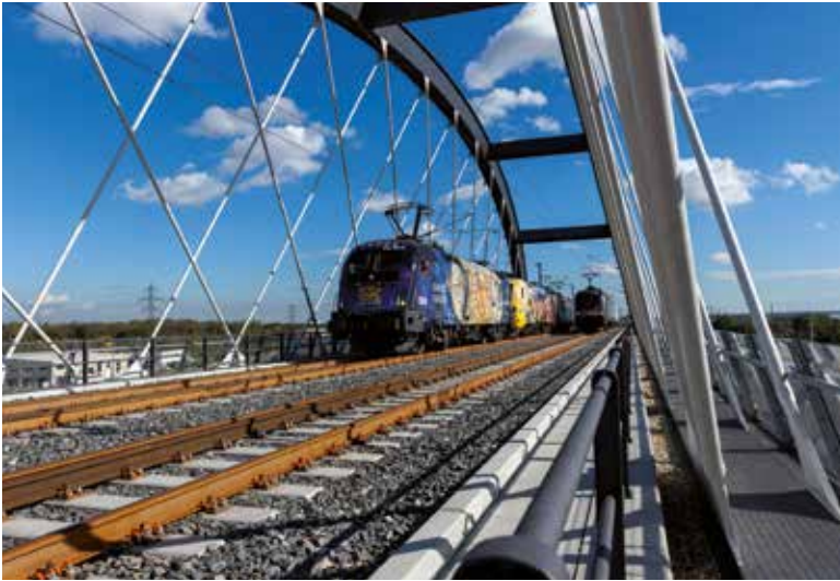
Den ÖBB lieferte der Stahlbauer zwei Netzwerkbogenbrücken für eine Verbindung zum Wiener Flughafen.
