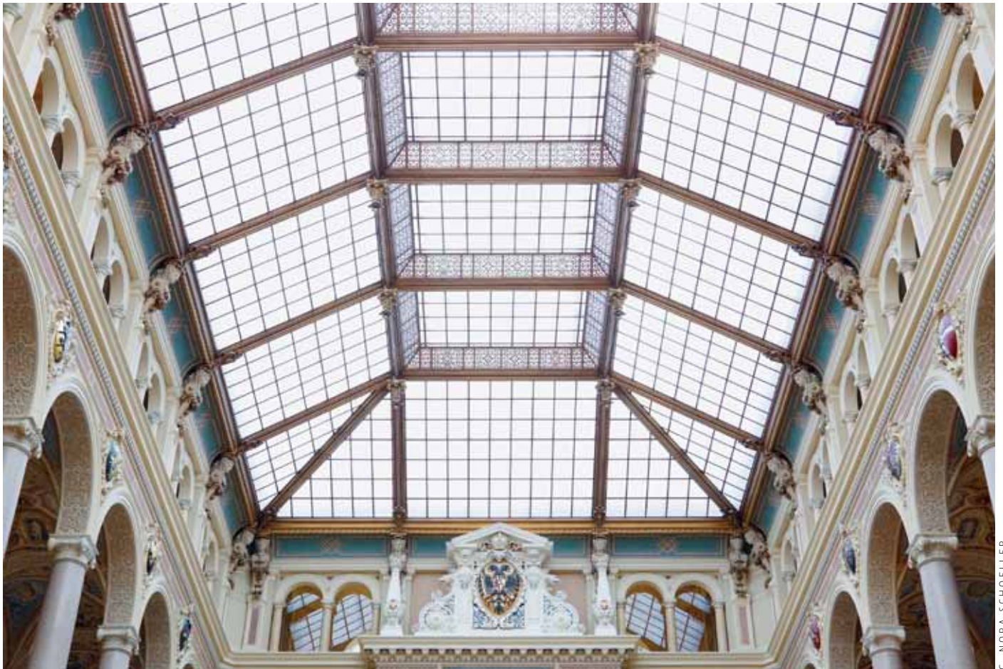
Justizpalast, Dach über der Zentralhalle
