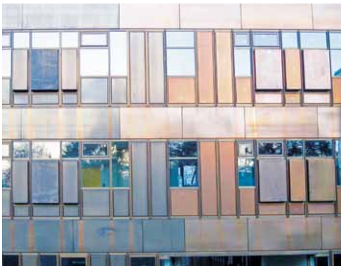
Fassade der „Rostlaube“ (Freie Universität Berlin) aus COR-TEN-Stahl
