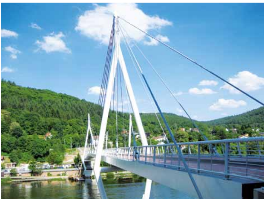
Neckarbrücke Zwingenberg (Einreichung zum SOLID Bautechpreis 2012, International)
