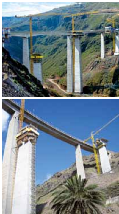
Für den Bau des 432 m langen und über 100 m hohen Viaducto De Guia Pagador auf Gran Canaria lieferte Doka ein Schalungskomplettpaket.
