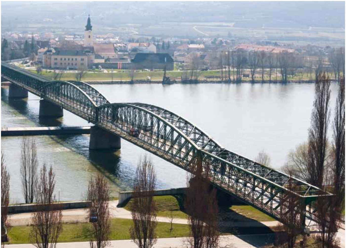
Brücke über die Donau zwischen Stein und Mautern (Niederösterreich)
