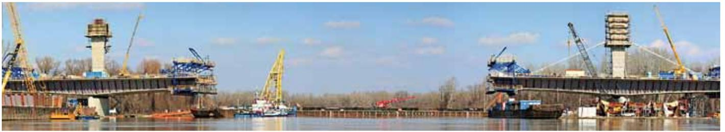
Die Tisza-Bridge im ungarischen Szeged vereint die Baumethoden von extradosed bridges und klassischen Stahl-Beton-Verbundbrücken.
