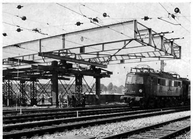
kenswert niedrig. Die verwendeten Stahlsorten waren St 52 T für die Tragkonstruktion, St 44 T für die Verbände, Querscheiben und St 37 T für Fahrbahnübergänge, Geländer usw.
