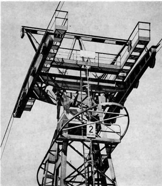
Stützenkopf einer Zweiseilbahn (Zetttersfeldbahn)
