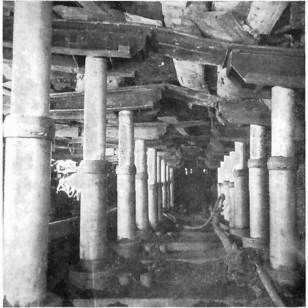
Bild 8: O.A.M.G., Bergla: Hydraulischer Schlepprahmen, Einsatz Untertage
