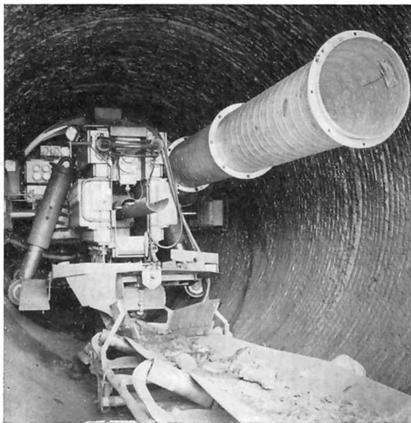
Bild 10: O.A.M.G., Köflach – Tagbau-Süd: Streckenvortriebsmaschine
