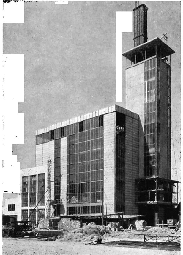
träger der hängenden Kessel ersetzen können, wodurch eine weitergehende Ersparnis an Gewicht und eine vollkommene Freiheit des Raumes innerhalb des Kessels von allen Stützen gegeben wird. Die Konstruktion des Kesselgerüsts selbst, und besonders bei stehender Ausführung, bietet dem Stahlbauer noch eine Reihe von Aufgaben, die es wesentlich erscheinen lassen, dieser Konstruktion größeres Augenmerk zuzuwenden, um weitere wirtschaftliche Lösungen zu finden.
