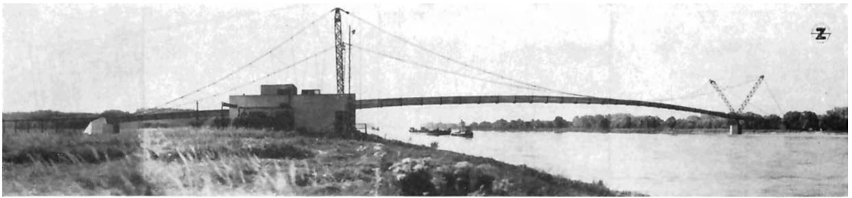
Bild 2: Photomontage der projektierten Rohrbrücke zur Überbrückung der Donau vom Tanklager Lobau zur neuen Raffinerie Schwechat der ÖMV-AG
