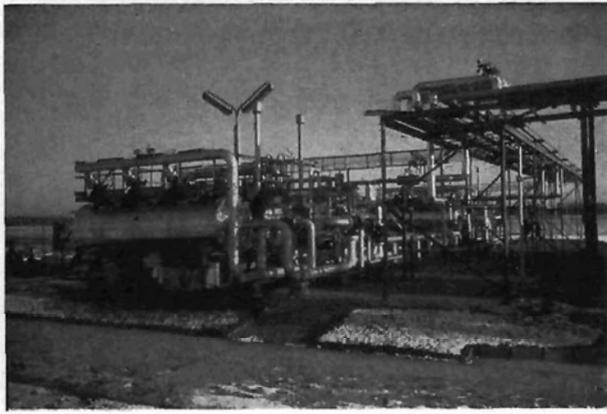
Bild 5: Festbett-Trocknungsanlagen zur Absenkung des Taupunktes auf  $-12^{\circ}\text{C}$  bei 60 ata
