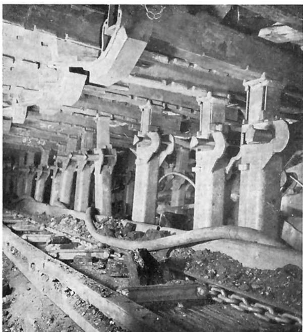
Eine in Stahl ausgebaute Strecke hat demgegenüber lange Standdauer, geringe Querschnittsverluste und hohe Betriebssicherheit.
