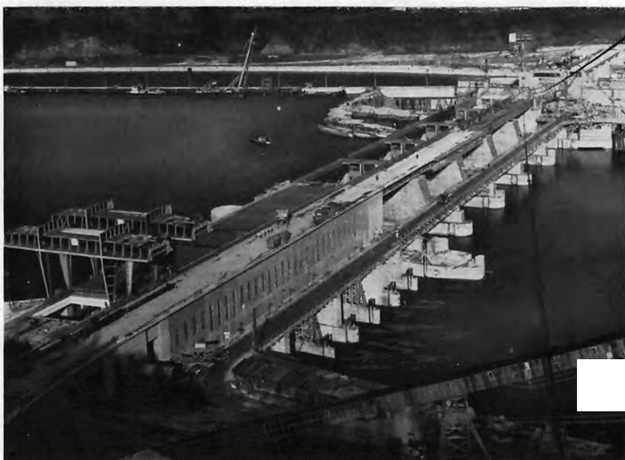
Bild 5: Donaukraftwerk Ybbs-Persenbeug, vorne fertiges Südkraftwerk, anschließend Wehr und Baugrube für das Nordkraftwerk
