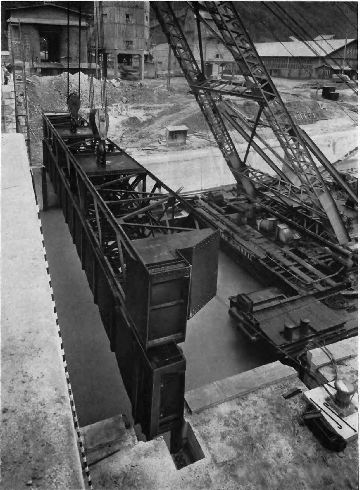
Einsetzen der Dammtafeln beim Donaukraftwerk Jochenstein Installed bulkhead gate leaves, Danube Power Station Jochenstein Mise en place des vannes dans la Centrale électrique de Jochenstein sur le Danube
