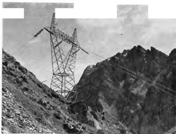
Bild 7: Abspannmast der 220-kV-Leitung Lienz—Pelos
