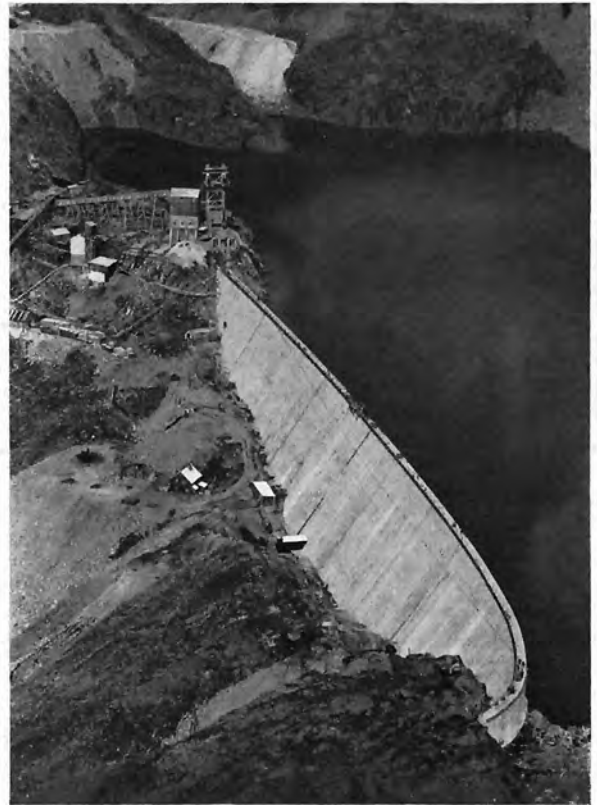
Bild 3: Winterspeicherwerk Reifheck-Kreuzeck, Staumauer „Großer Mühlendorfersee“
