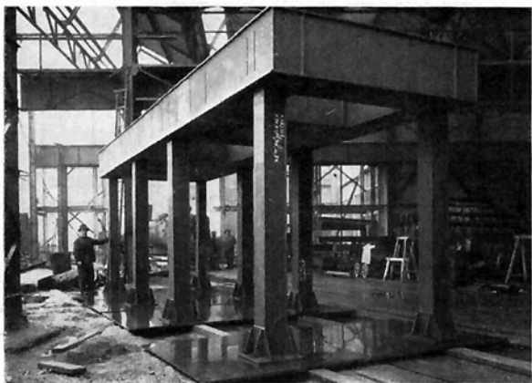
Bild 8: Tief abgestimmtes Stahlfundament aus geschweißten Kastenprofilen für Dampfturbinen
