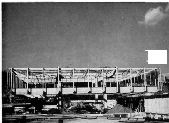
Bild 6: Fertigmontage der Stahlkonstruktion am Österreich-Pavillon im Oktober 1957. Südansicht
