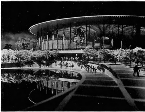
Bild 2: Der Pavillon der USA auf der Weltausstellung Brüssel 1958 wird das größte kreisförmige Gebäude der Welt sein. Wände, Zwischenwände und Dach bestehen aus Plastikmaterial, als Decke ist ein Metallnetz aufgehängt
