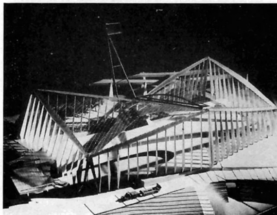
Bild 1: Der französische Pavillon auf der Weltausstellung Brüssel 1958 hat nur eine einzige Auflagerung (vorne im Bild). Der gerade Pfeil dient als Gegengewicht
