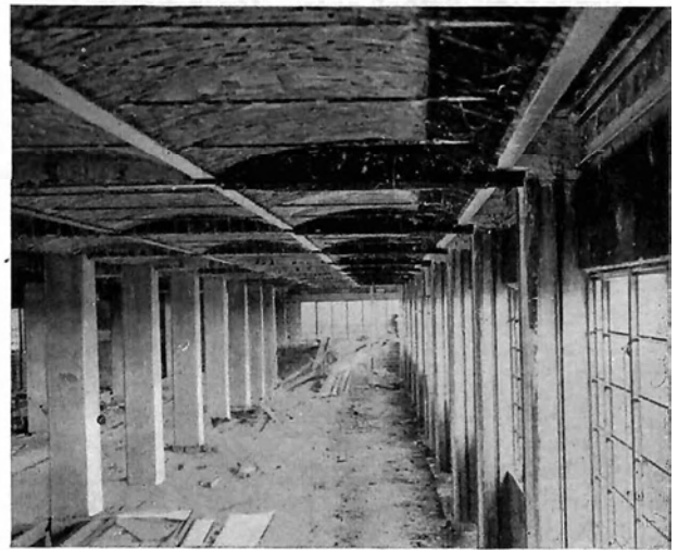
Bild 21: Dämmung der Unterzüge, des äußersten Längsträgers, des Ziegelgewölbes und des Außenmauerwerkes mit Kork, der Stützen mit Zellenbeton, vom Bau der Tabakfabrik Linz
