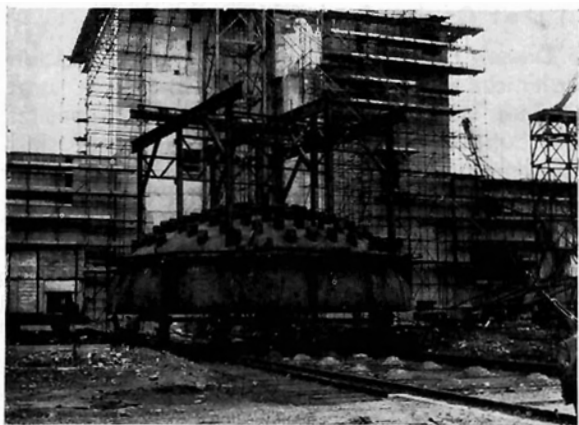
Bild 11: Druckbehälter des Reaktors in Calder Hall — Oberer Behälterboden fertig zum Einbau
