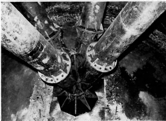
Bild 5: Tiefblick auf den Fußpunkt des Gerüsts
