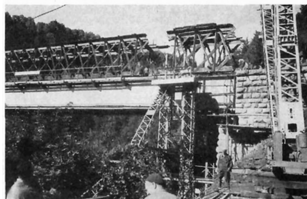
Bild 7a: Demontage des alten Tragwerkes
