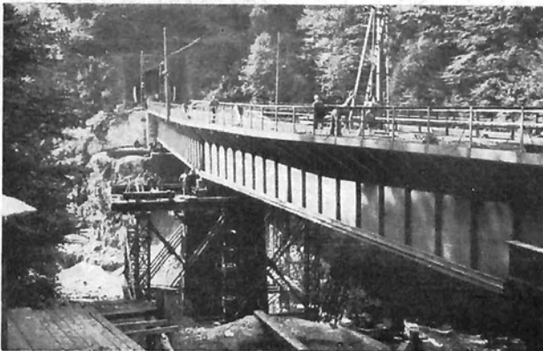
Bild 4d: Ansicht der neuen Brücke unmittelbar nach dem Einschub
