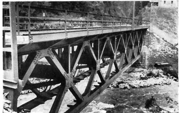
Bild 5b: Ansicht der neuen Brücke
