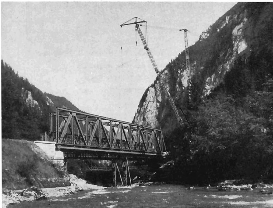
Bild 8a: Ansicht der neuen Brücke. Im Hintergrund altes Tragwerk und dahinter Straßenbrücke
