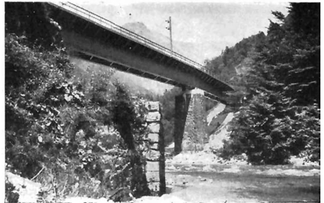
Bild 4f: Ansicht der neuen Brücke
