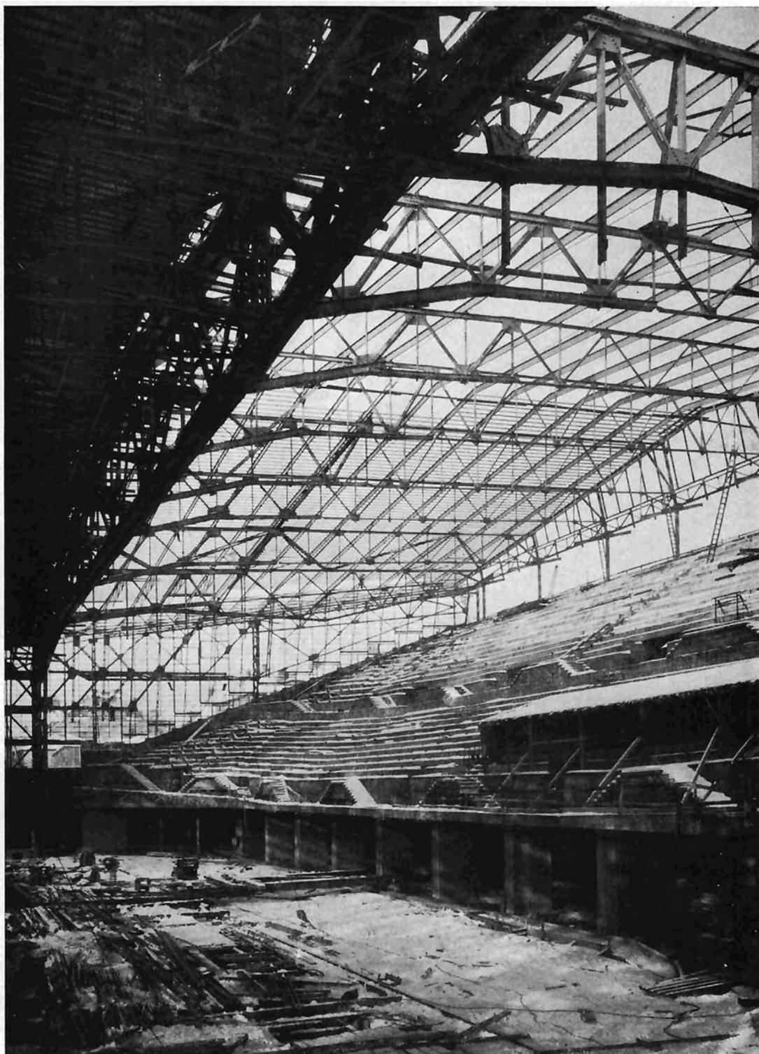
Lieferung und Montage der freitragenden Stahldachkonstruktion im Grundriß 100x110 m für die neue Wiener Stadthalle, gemäß unserer Projektausarbeitung. Gesamtliefergewicht ca. 1800 Tonnen.
