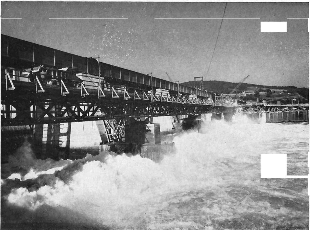
eine aufschraubbare Verstärkung zu G 8 als neuen Geräteteil einzuführen. Diese Verstärkung sowie die Ausbildung eines durch den Pfeilerabstand erforderlichen 1,5-m-Feldes sind aus Bild 11 ersichtlich. Um beim Freivorbau noch 1,5 m zu gewinnen, wurde am Auflager eine herausnehmbare Hilfsdiagonale eingezogen, wodurch der für die Gurtkräfte maßgebende Momentenpunkt in die Feldmitte rückte.
