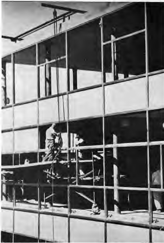
Bild 5: Montage der Wandverkleidungselemente Fig. 5: Installation of wall lining elements
