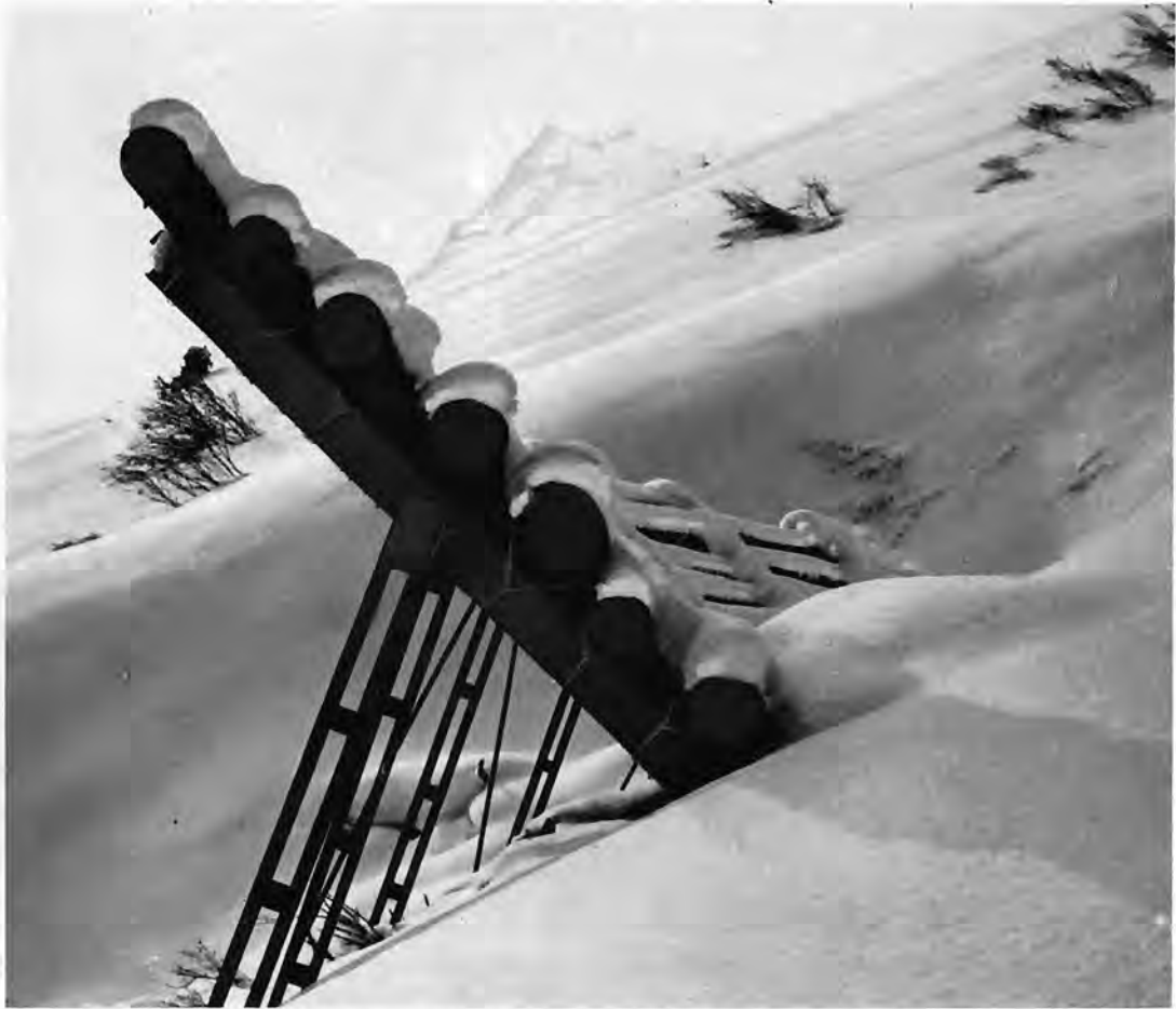
Bild 9: Schneebrücke der Tescher-Lawine nach vollendeter Montage
