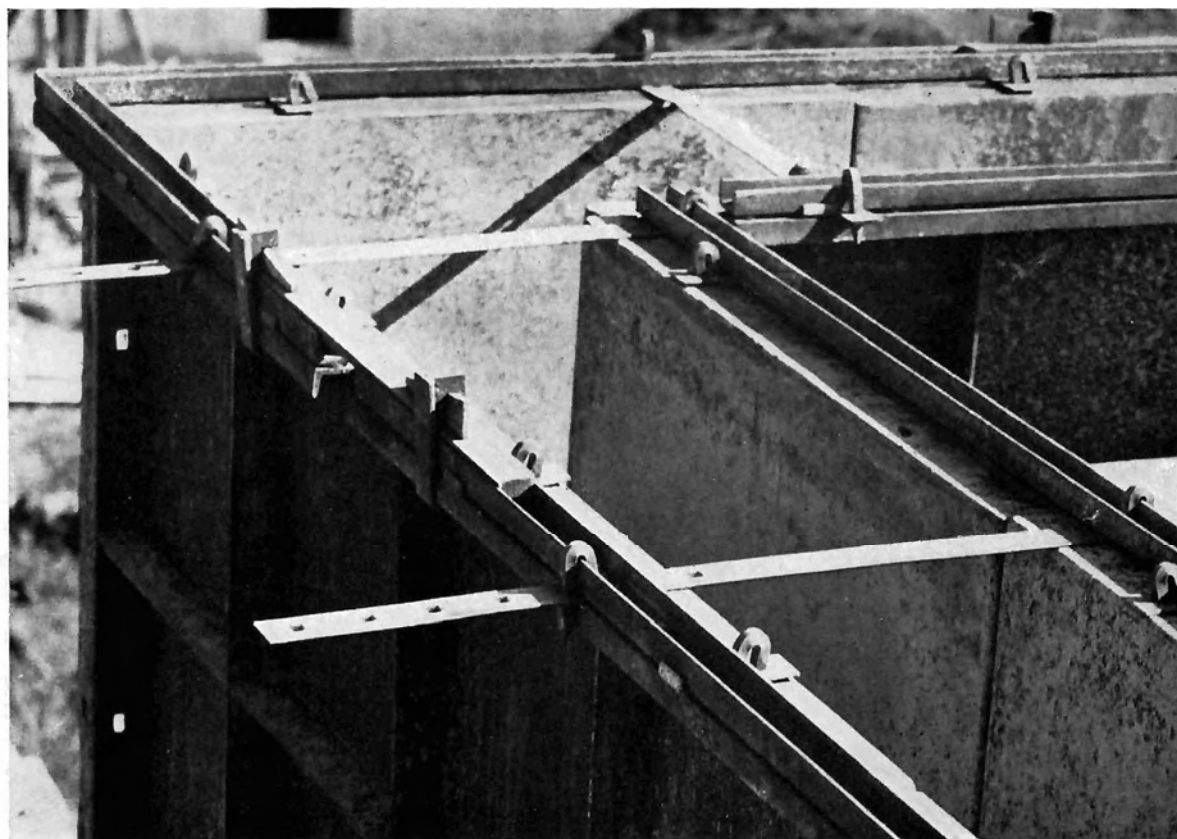
Bild 4: Anordnung der Stahl-Bauschalung bei einer Mauerkante
