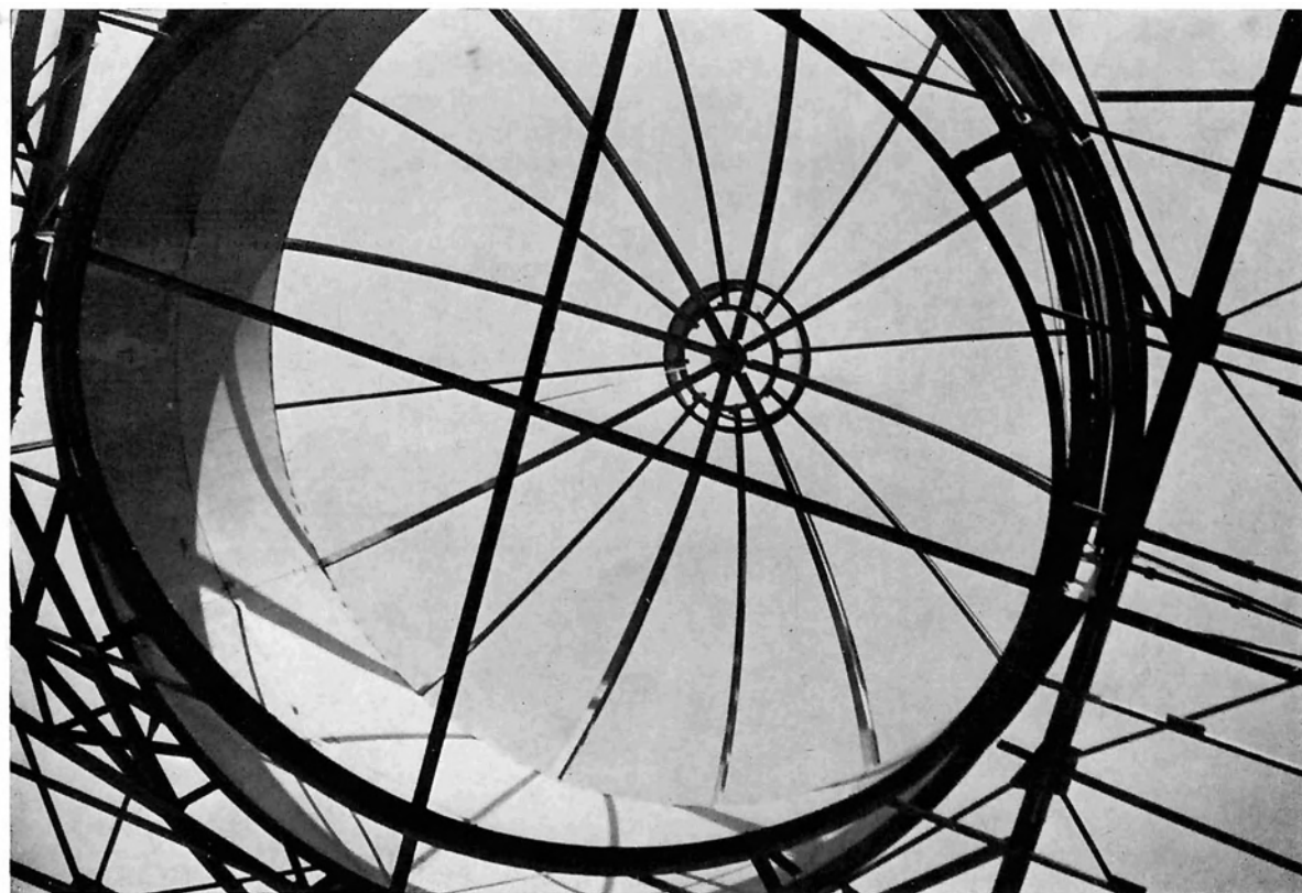
Bild 3: Untersicht in die Kuppelstahlkonstruktion
