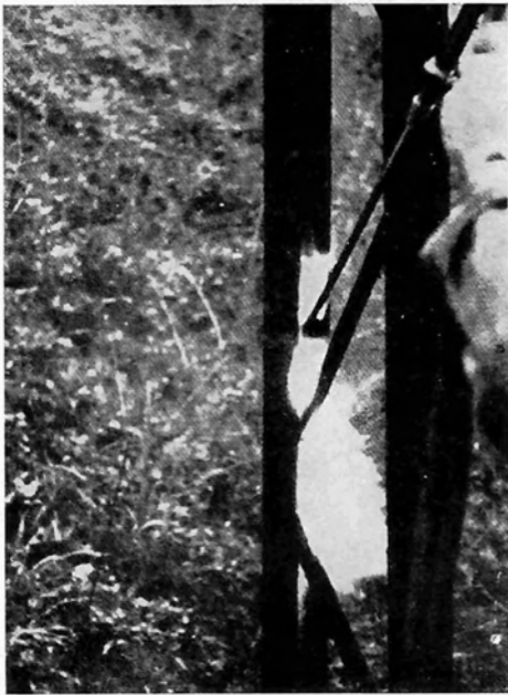
Bild 4: Entrostung bei Rohr- und Gittermasten mittels des Flammstrahlers
