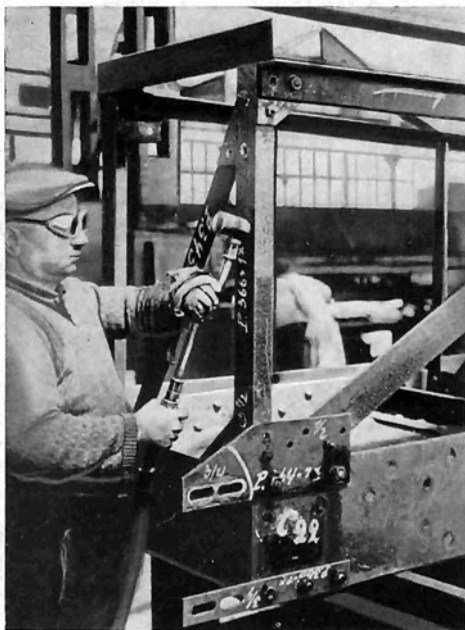
Bild 1: Entrostung mit rotierender Drahtbürste Fig. 1: Derusting with rotating wire brush
