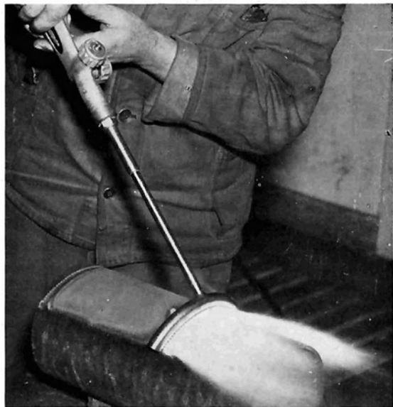
Bild 2: Spezialbrenner für Rohre mit richtiger Brennerhaltung während der Arbeit
