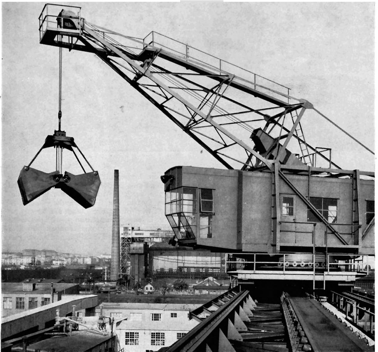
Bild 2: Drehkran einer Kohlenverladebrücke mit Förderbändern im Obergurt Fig. 2: Swing crane of coal loading bridge with belt conveyor in top flange
