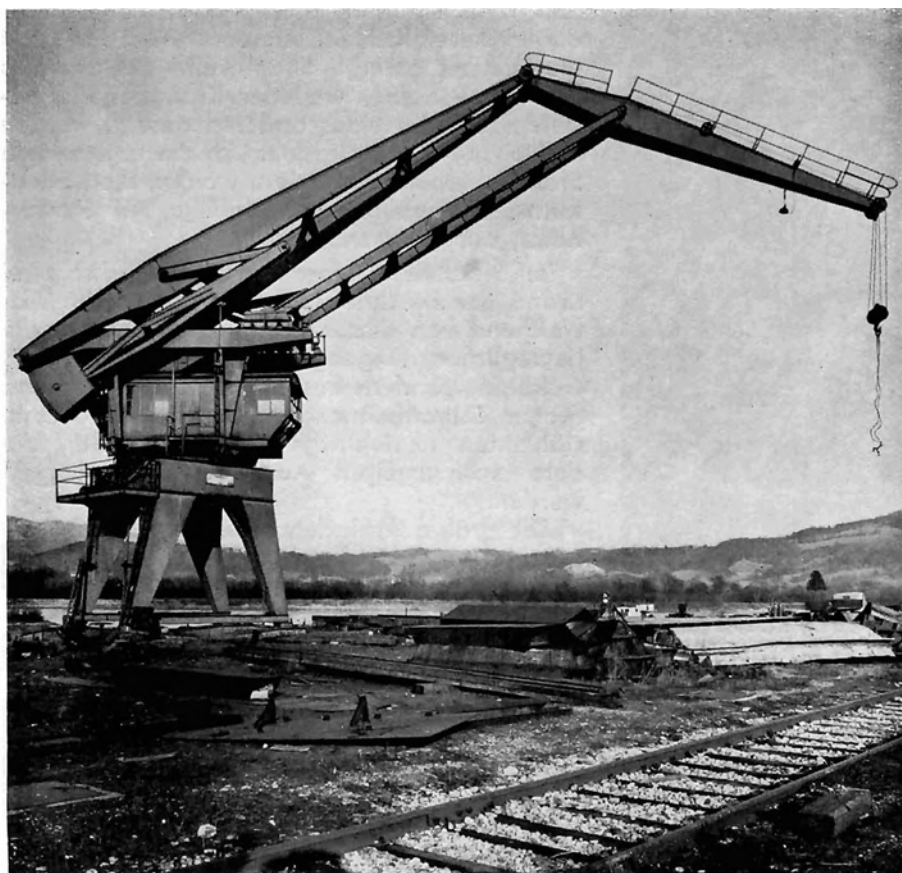
Bild 3: Storchschnabel-Wippdrehkran mit ganz eingezogenem Ausleger
