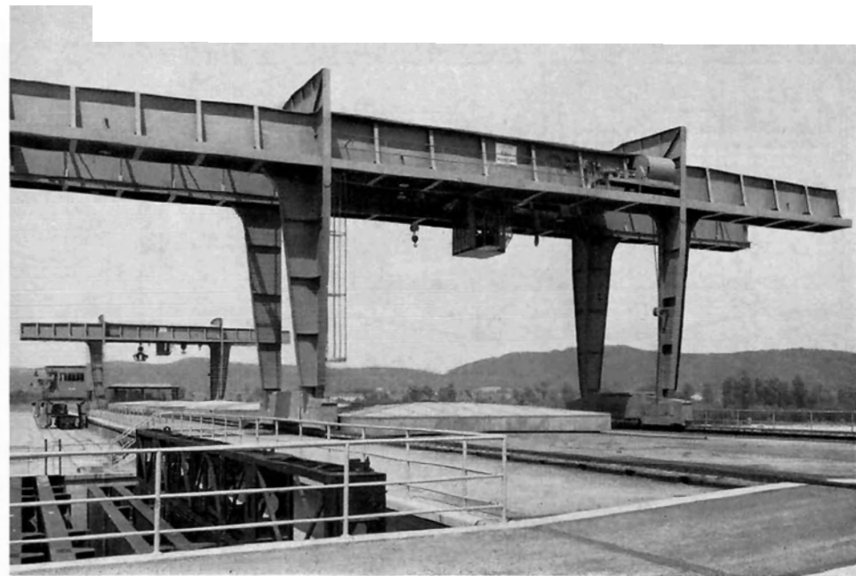
Bild 5: Die gleichen Krane wie Bild 4 in der Ansicht von Unterwasser
