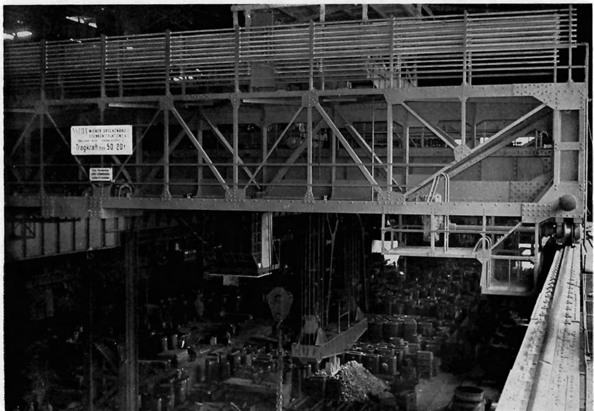
Bild 7: Gesamtansicht des 50/20-t X 25 m-Gießkranes, 1956
