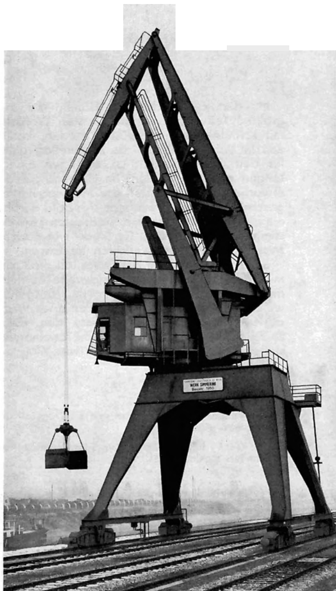
Bild 3: Storchschnabel-Wippdrehkran mit ganz eingezogenem Ausleger
