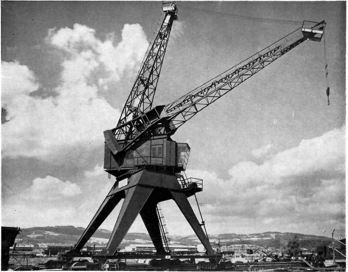
Bild 6: Vollportal-Wippdrehkran nach Bild 5 bei max. Ausladung von 22 m Fig. 6: Gantry luffing swing crane (Fig. 5) at max. outreach of 22 meters
