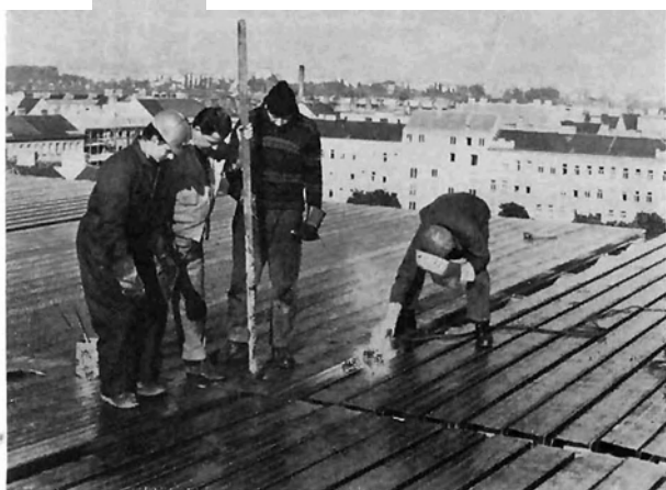
Bild 8: Verlegen der aus verzinkten Stahlprofilen vorgefertigten Blechdielen
