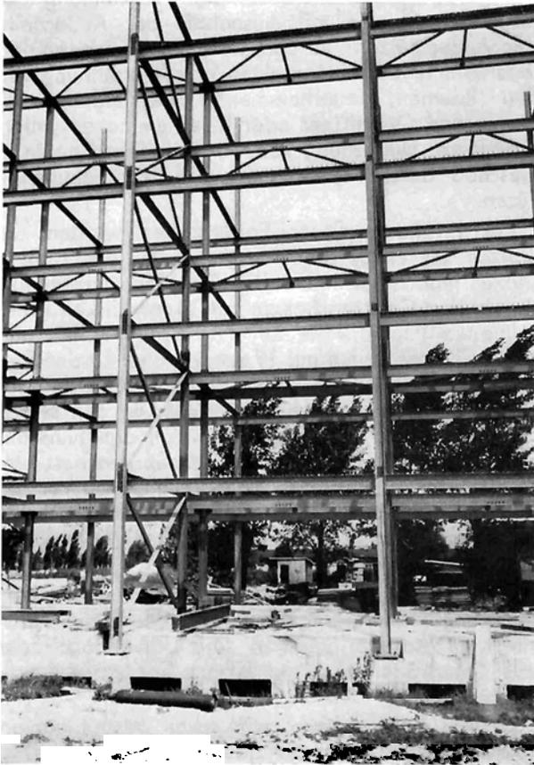
Die Querriegel werden durch Decken und Wände nicht direkt belastet, sondern nur über den innerhalb der Außenstützen aufgehängten Außenlängsträger, so daß sie nur geringfügige Biegemomente erhalten. Am Gebäudeende wurden die unmittelbar auf den Querriegel aufbetonierten Deckenränder bis zum Erhärten des Betons unterstützt und entsprechend bewehrt, so daß auch dort mit den schwachen Querriegeln (HE 180) das Auslangen gefunden wurde.
