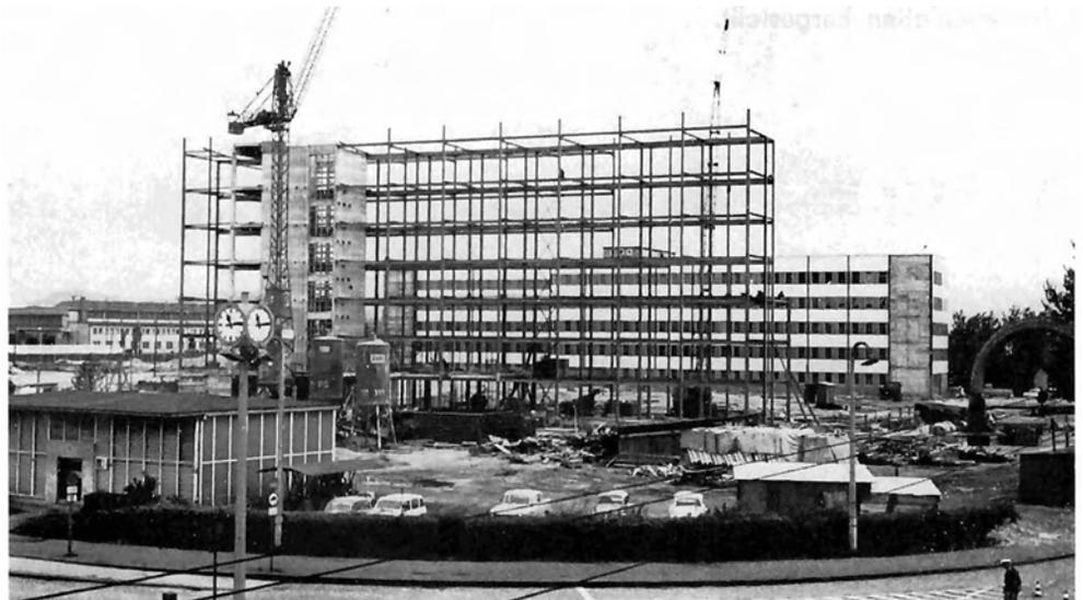
Von den drei Bürogebäuden wurde das erste mit vier Obergeschossen, das zweite mit sechs Obergeschossen und das dritte mit vier Obergeschossen, aber einer Aufstockungsmöglichkeit von zwei weiteren Geschossen ausgebildet. Dabei ergaben sich unter Abzug des Massivkernanteiles die nachstehenden Werte für die Kubaturen umbauten Raumes, die Konstruktionsgewichte und den Stahlbedarf in  $\text{kg/m}^3$ :
