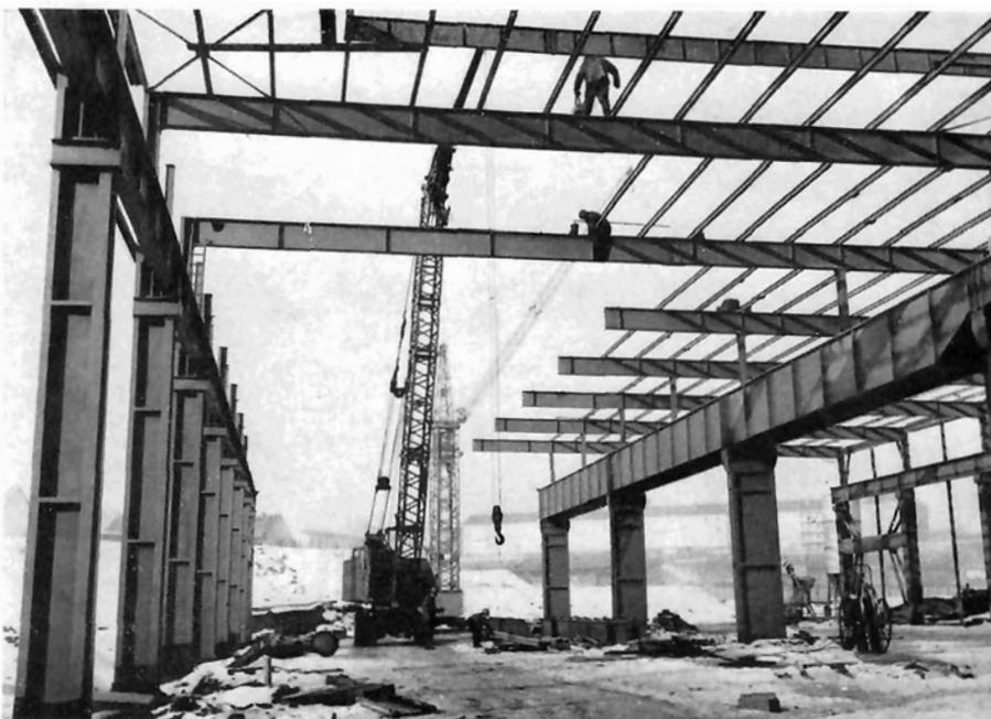
Bild 1: Neue Maschinenmontagehalle der OAMG, Werk Zeltweg, Stahlbaumontage
