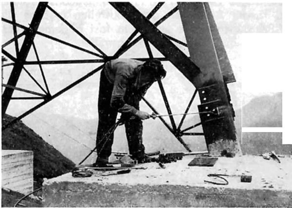
Bild 2: Flammstrahlen der Berührungsfläche
