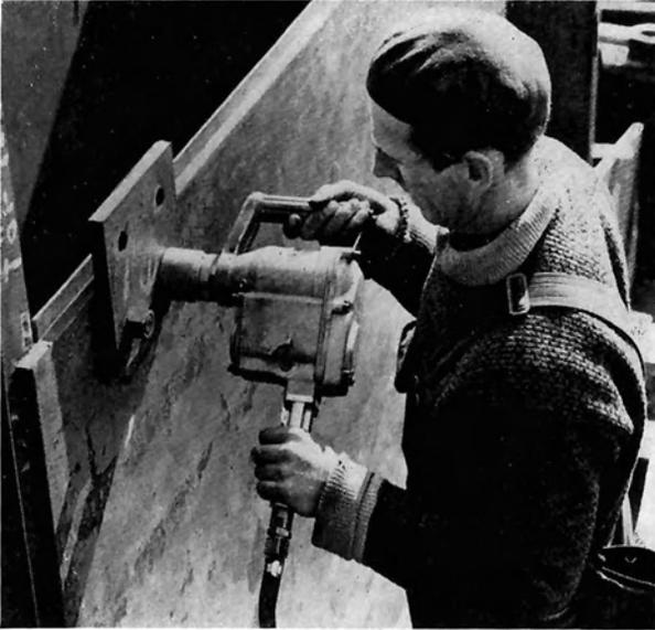
Bild 23: Schlagschrauber im Einsatz auf einer Baustelle, Fabrikat: Atlas Copco LMS 41
