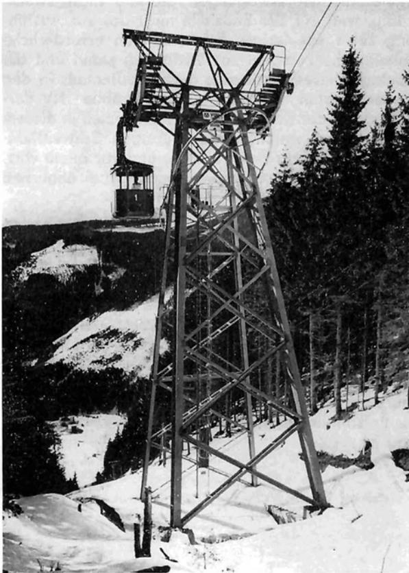
Bild 5: HV-verschraubte Seilbahnstütze der Sonnenalm-
