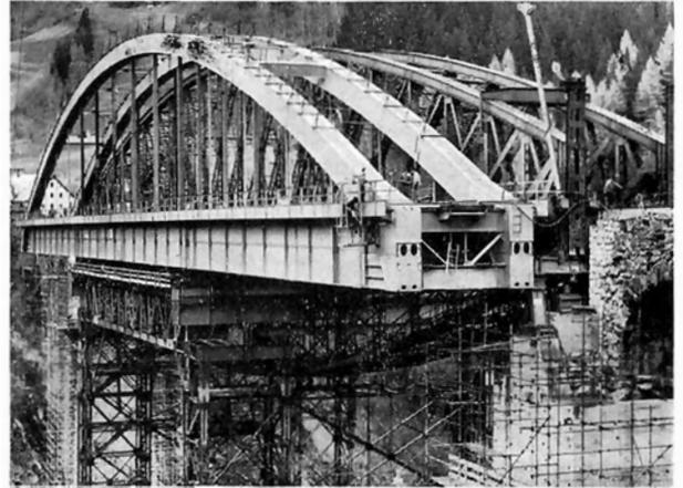
bahnen, wurde das gesamte Tragwerk und somit auch die Verbindungsstellen in der Werkstätte sandgestrahlt. An der Baustelle wurden die Berührungsflächen der Stöße vor der HV-Verschraubung flammgestrahlt.
