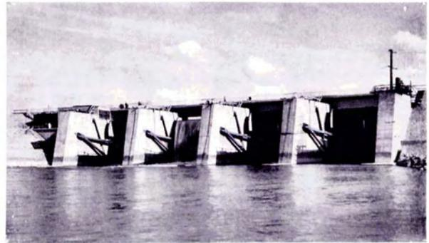
Bild 11: Klappensegmentwehr des KW St. Pantaleon
