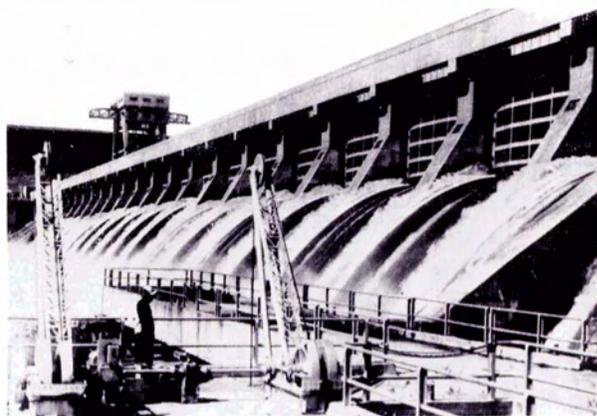
Bild 3: Verschlüsse des Kraftwerkes McNary
