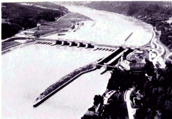
Bis jetzt wurden in Ybbs-Persenbeug rund 8500 GWh erzeugt. Im Stauraum der Stufe Ybbs gelang es, die gefürchteten Schifffahrtshindernisse im Strudengau zu beseitigen. Durch das Wegsprengen der Sarlinger Schwelle im Winter 1962/63 wurden auch im Unterwasser des Kraftwerkes einwandfreie Schifffahrtsverhältnisse geschaffen.
