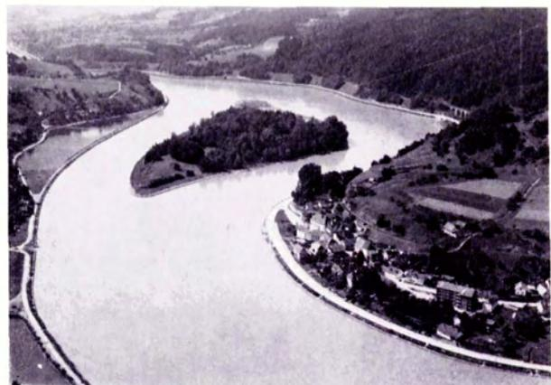
Bild 9: Die Stadt Grein und die zügige Uferführung nach Absprengung des Schwallecks
