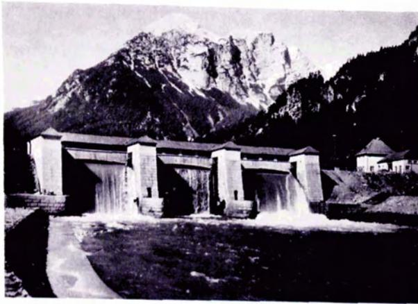
Bild 9: Klappensegmentwehr des KW Hieflau
