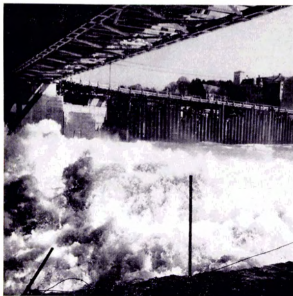
Bild 3: Deckwalze im Tosbecken bei angehobenem Unterschlütz
