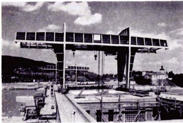
Bild 1: Zwillingportalkran mit je 130t Tragkraft mit innenfahrenden Laufkatzen und Kranbrücken in geschweißter Vollwand-Bauweise, geliefert für das Donaukraftwerk Ybbs-Persenbeug der DoKW
