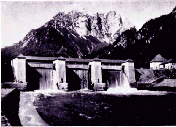
Bild 1: Klappensegmentwehr des KW Hieflau
