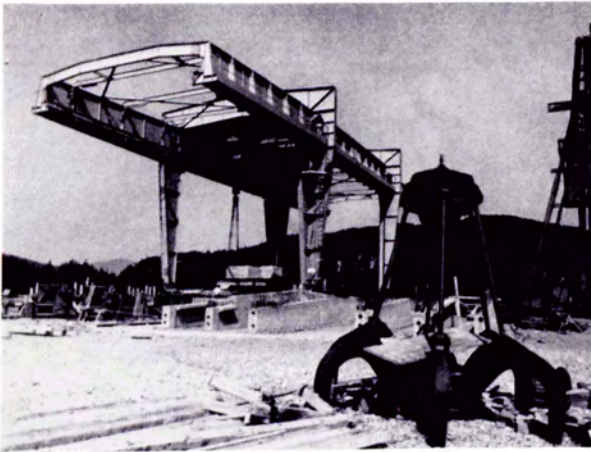
Bild 8: 54-t-Portalkran mit innenfahrender Laufkatze und Doppelhubwerk beim Anheben der Probelast im Kraftwerk Edling der Österr. Draukraftwerke AG. Im Vordergrund der Polypgreifer, der am Auslegerhubwerk fallweise eingesetzt wird
