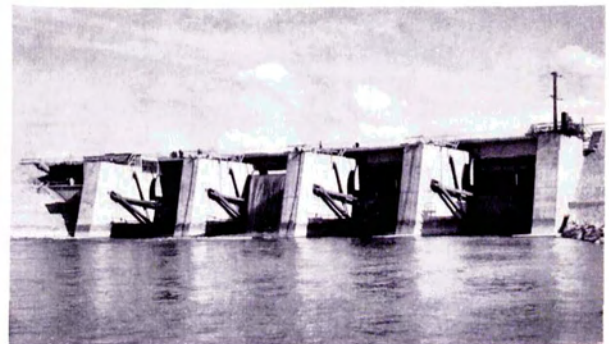
Bild 5: Klappensegmentwehr des KW St. Pantaleon
