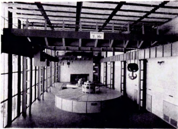
Bild 20: Zwei Maschinenhauslaufkrane mit je 95 t Tragkraft, geliefert für das Kraftwerk St. Pantaleon der Ennskraftwerke AG. Die Katzfahrschienen sind auf den vollwandigen Hauptträgern angeordnet, die Nebenträger sind aus vollwandigen Kanträgerprofilen hergestellt
