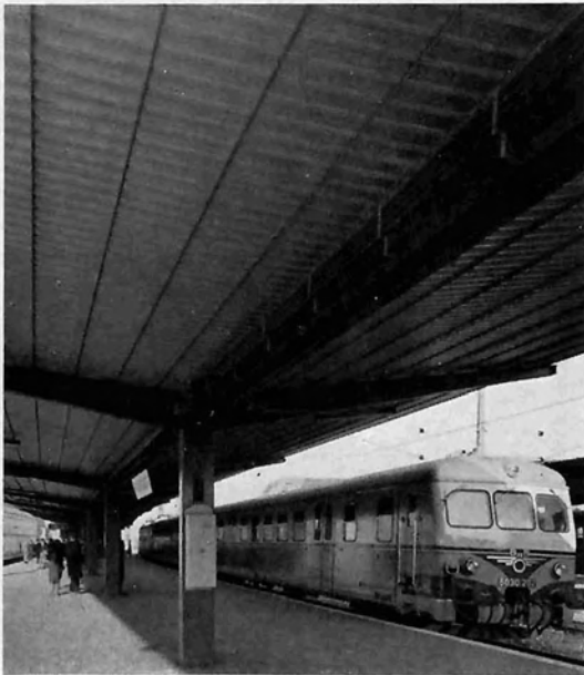
Spanndrahtdach der Schnellbahnstation Floridsdorf
