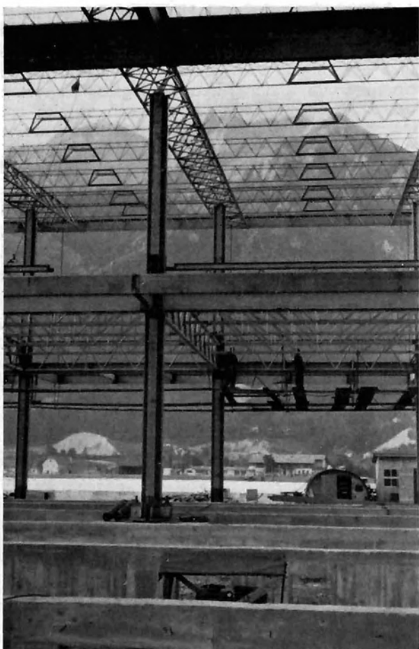
Bild 9: Empfangsgebäude Flughafen Innsbruck – Deckenkonstruktion
