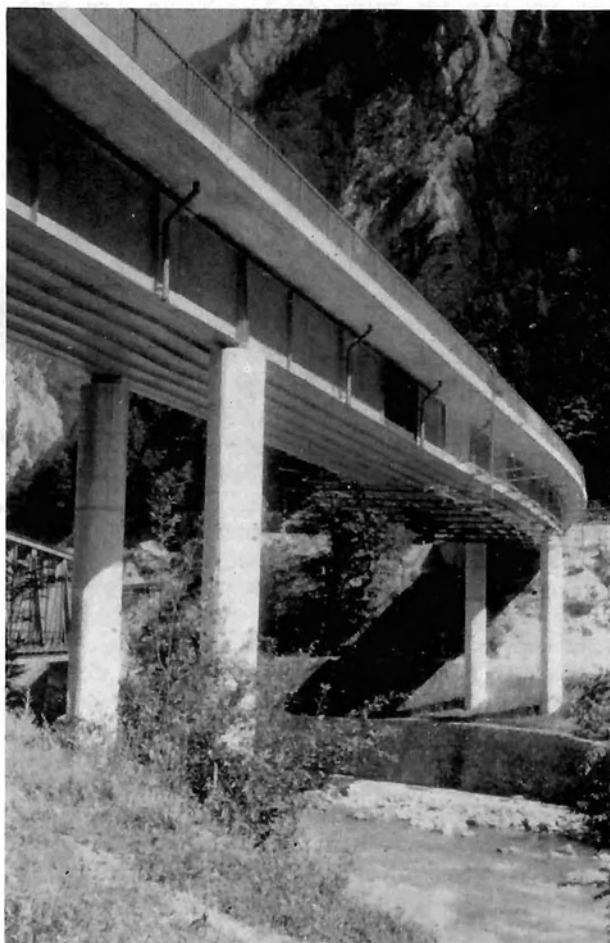
Bild 11: Straßenbrücke über die Enns mit vorgespannter Betonplatte
