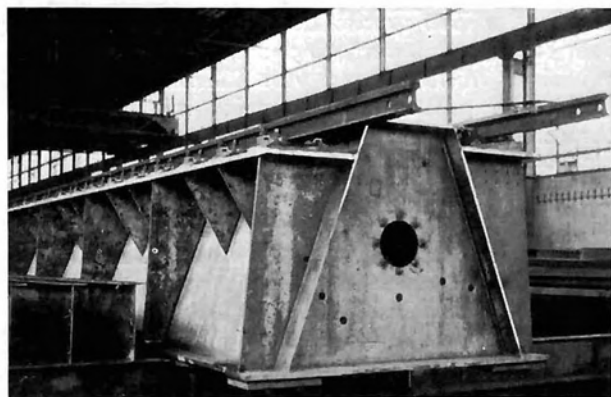
Bild 13: Kleine Eisenbahnbrücke mit Hohlkasten-Querschnitt
