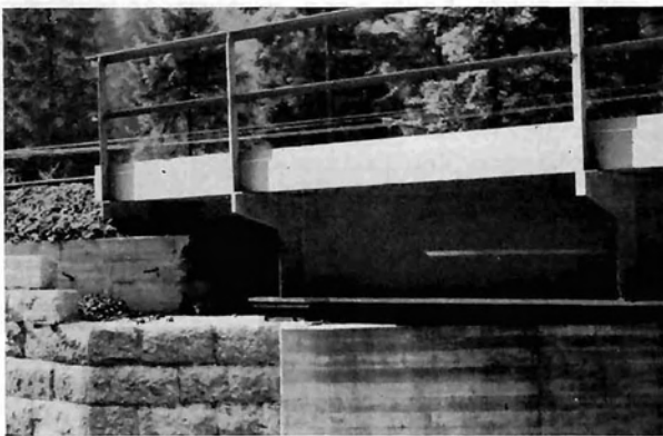
Bild 17: Eisenbahnbrücke mit Neoprene-Lagern
