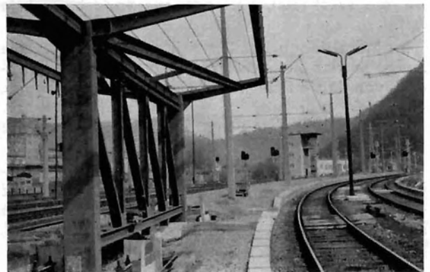
Bild 4: Endverankerung des Spannstadhdaches
