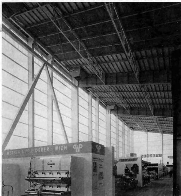
Bild 2: Die 29 m hohe Nordostwand mit 27,2 m langen Windstreben; Profilverglasung (Foto Zisser, Wien)
