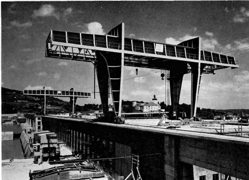
Bild 14: Wehrkran Ybbs-Persenbeug/Donaukraftwerke, 130 t Tragfähigkeit, Spannweite 11+16+11 m
