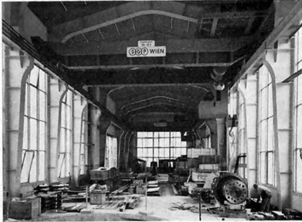
Bild 21: Maschinenhauskrane Schwarzach/Tauernkraftwerke, 50/10 t Tragkraft, 11 m Spannweite
