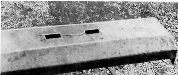
Bild 21: Gelochte Stahlschwelle, Schwellendecke eingrisen
