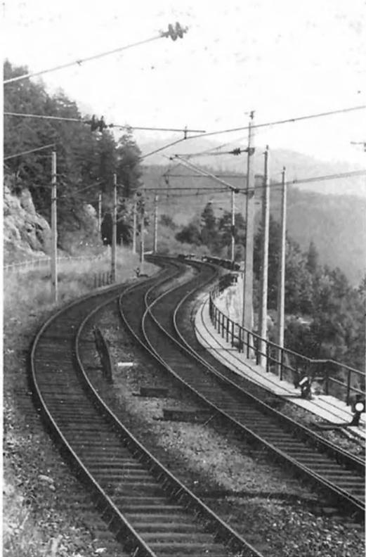
Bild 27: Bogenweichen am Nordkopf des Bahnhofes Semmering
