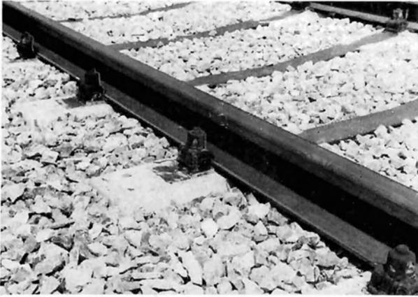
Bild 20: Zweiblock-Betonschwelle Form 22 mit Rippenplattenbefestigung
