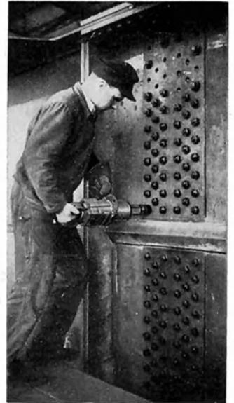
Schlagschrauber mit Drehmomentkontrolle beim Anziehen von hochfesten Schrauben im Brückenbau
