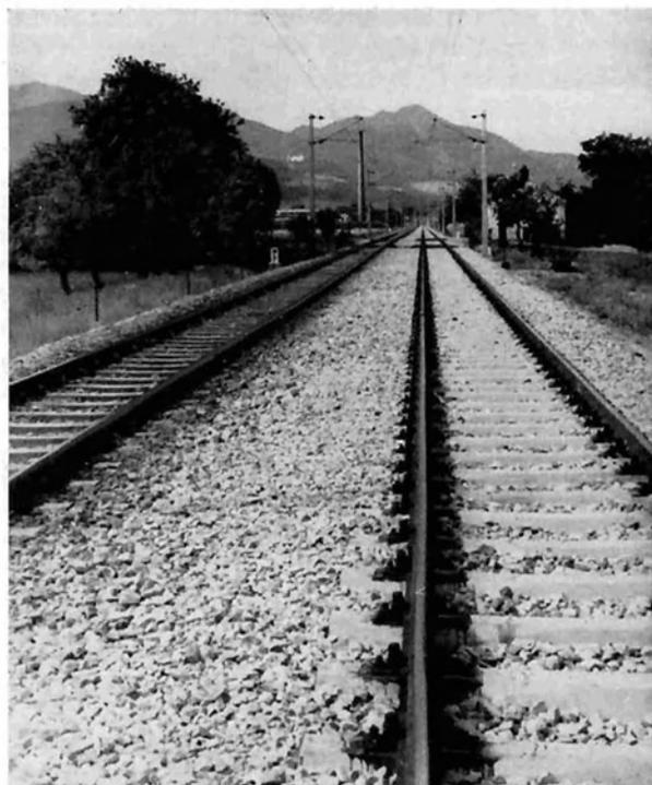
Bild 9: Lückenloses Gleis auf Stahlbetonschwellen der Form 12 zwischen Pottschach und Gloggnitz
