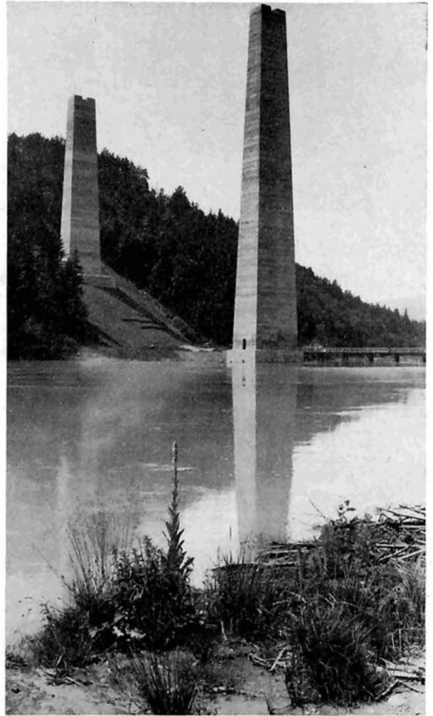
Bild 18: Jauntalbahndraubrücke, Hangpfeiler und Flußpfeiler.
