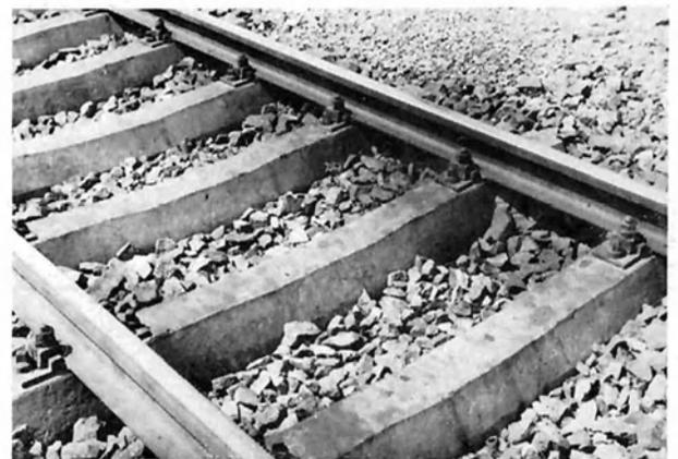
Bild 19: Vorgespannte Betonschwelle Form 11 mit Rippenplattenbefestigung
