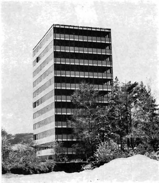
Das fertige Verwaltungsgebäude der Alpine Montan in Zeltweg
