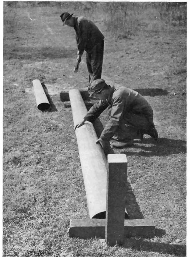
Bild 14: Zusammenbau eines Stahlleichtrohrmastes
