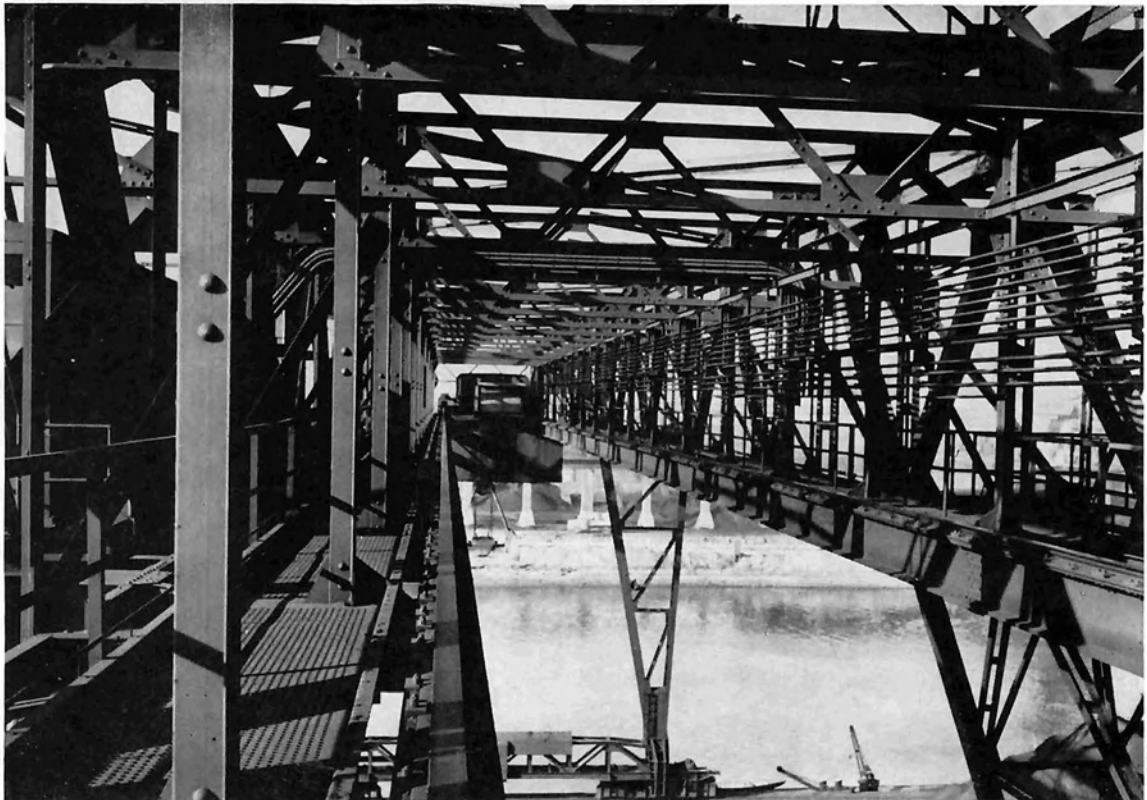
Erzverladebrücke, Tragkraft 25 t, mit Greiferbetrieb
