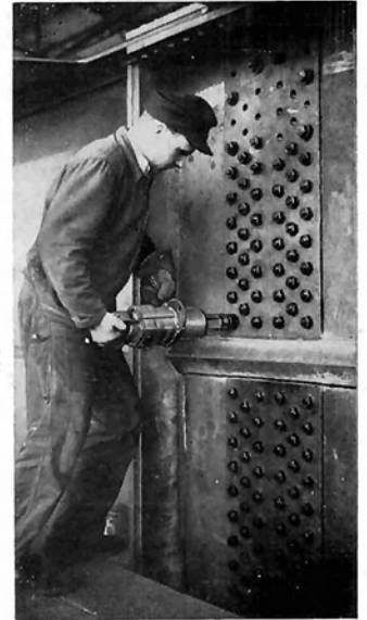
Schlagschrauber mit Drehmomentkontrolle beim Anziehen von hochfesten Schrauben im Brückenbau
