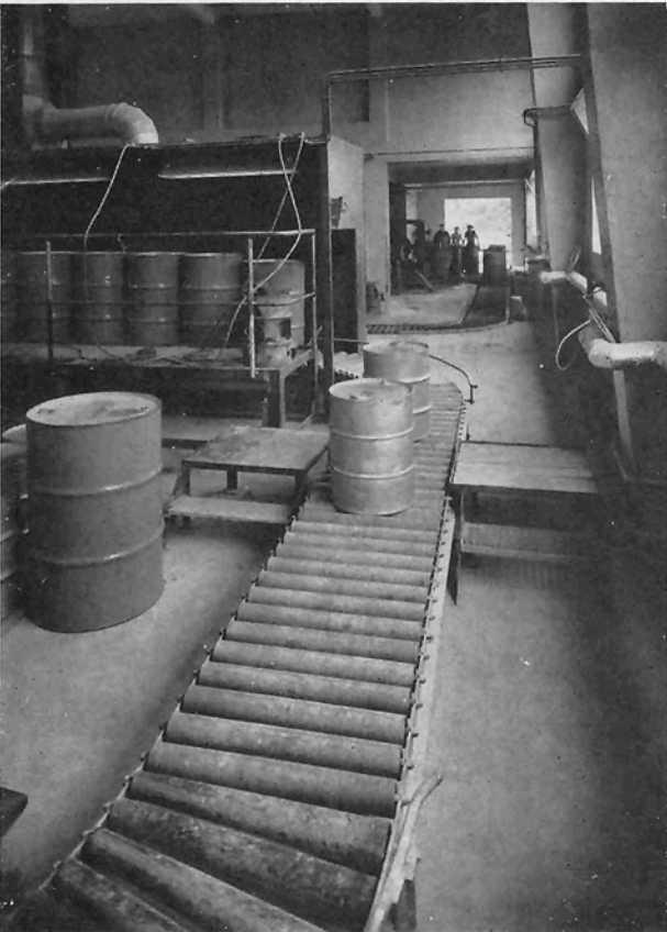
Bild 13: Rollenbahnanlage für Stahlfässer in einer Mineralölfabrik
