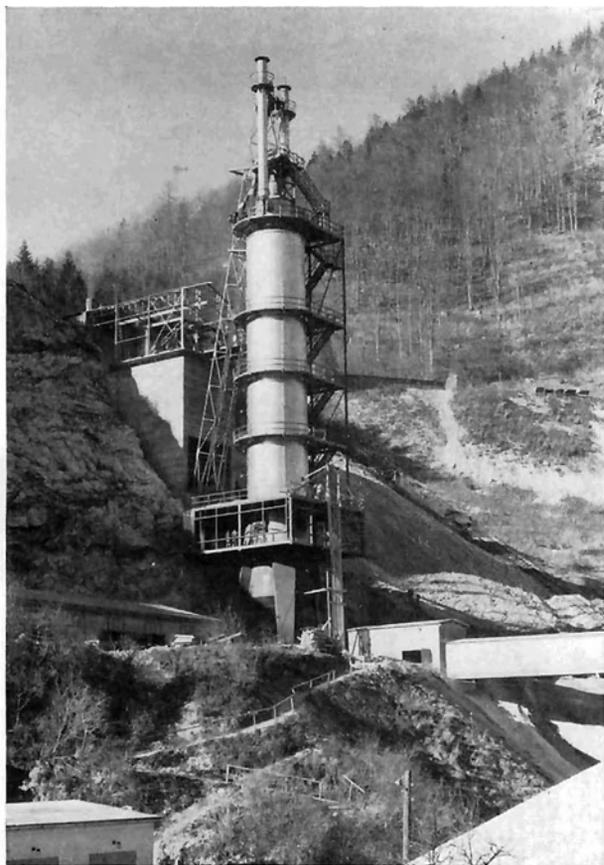
Bild 1: Der neue 180-t-Kalkschachtofen der VOEST in Steyrling
