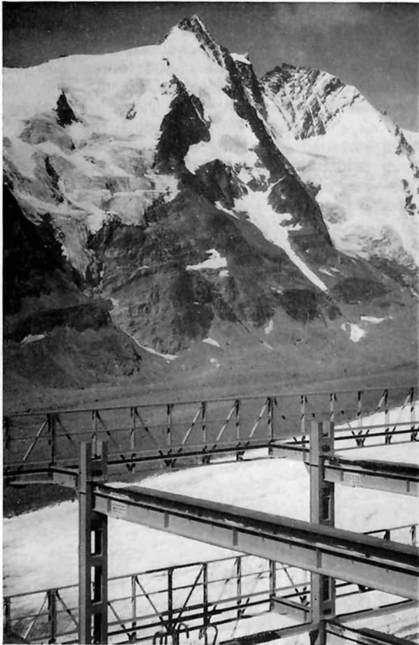
Bild 1: Stützen, für den Weiterbau ausgelegt, mit Geschosßriegel in +11,81 m und Fassadenträger
