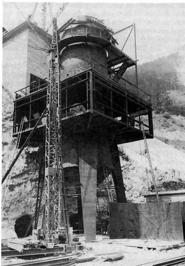
Bild 6: Das Ofengestell mit Bunker und Austragbühne
