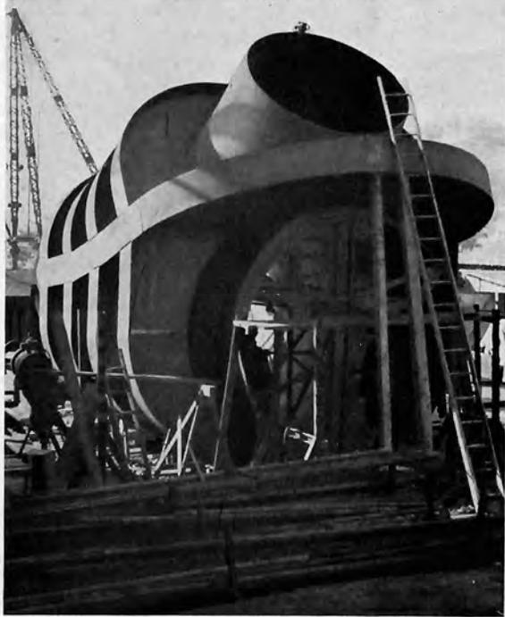
Bild 15: Hosenrohr für den gepanzerten Druckschacht des Innkraftwerkes Prutz-Imst der TIWAG.
