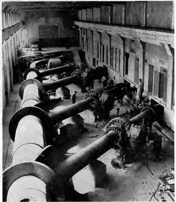
Bild 16: Verteilrohrleitung der Zentrale Riddes, Anlage Mauvoisin, Walliser Alpen, Schweiz. Gebrüder Sulzer AG, Winterthur.
