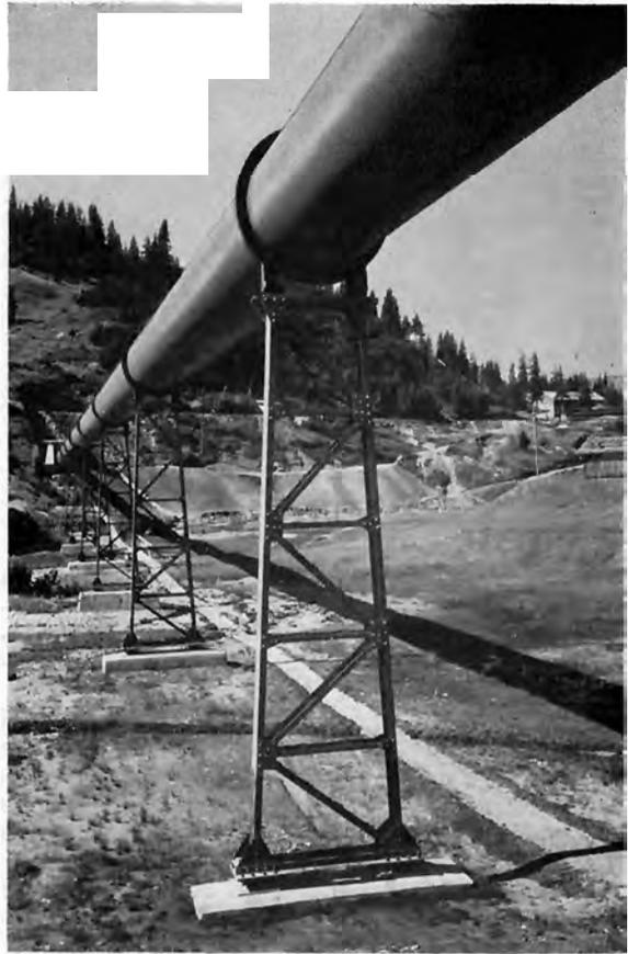
Bild 9: Rohrbrücke Kops der Bachüberleitungen nach Vermunt, Voralberger Jllwerke AG, VOEST-Linz
