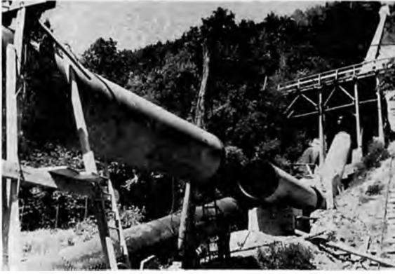
Bild 76: Druckrohrleitungsstrang II des Rannkraftwerkes der OKA; Montage. VÖEST-Linz. Links der alte, genietete Strang I
