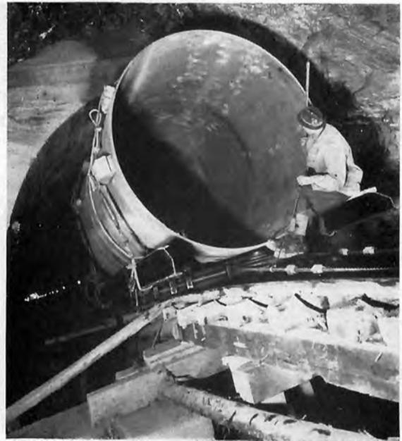
Bild 72: Rohrstoßenleitung des Kraftwerkes Uffendorf (Stubach III) der Österr. Bundesbahnen; Montage. Vgl. auch Bild 17. Waagner-Biró AG, Wien-Graz
