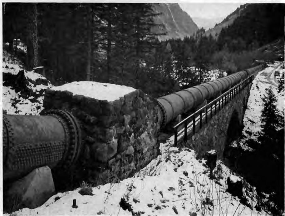
Bild 19: Festpunktblock einer freien Druckrohrleitung, Beton mit Bruchsteinverkleidung. Kraftwerk Schneiderau (Stubach II) der Österr. Bundesbahnen. Waagner-Biró AG, Wien-Graz
