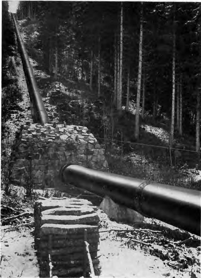
Bild 29: Druckrohrleitung des Kraftwerkes Schneiderau (Stubach II) der Österr. Bundesbahnen
