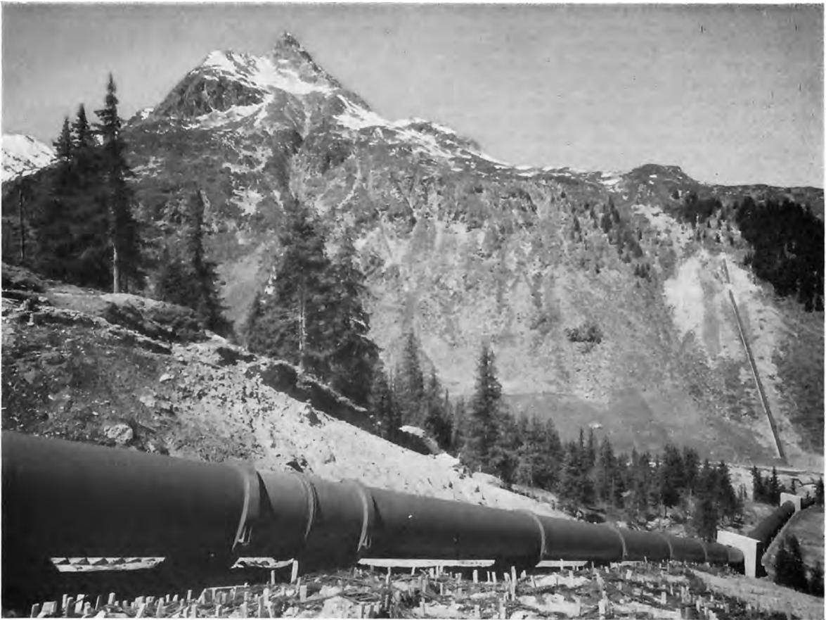
Bild 69: Taldücker Kleinvermunt der Bachüberleitungen nach Vermunt, VIW. Waagner-Biró AG, Wien-Graz
