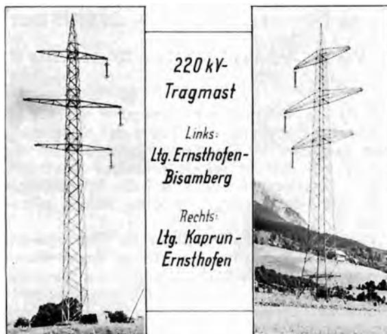
Bild 1: 220-kV-Tragmaste
