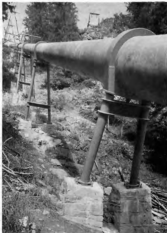
Bild 11: Druckrohrleitung des Kaiserbachkraftwerkes der TIWAG, Rohrbrücke. Waagner-Biró AG, Wien-Graz
