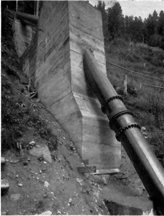
Bild 20: Festpunktblock bei Beginn einer Steilstrecke. Druckrohrleitung des Kraftwerkes Deban II der TIWAG. Waagner-Biró AG, Wien-Graz
