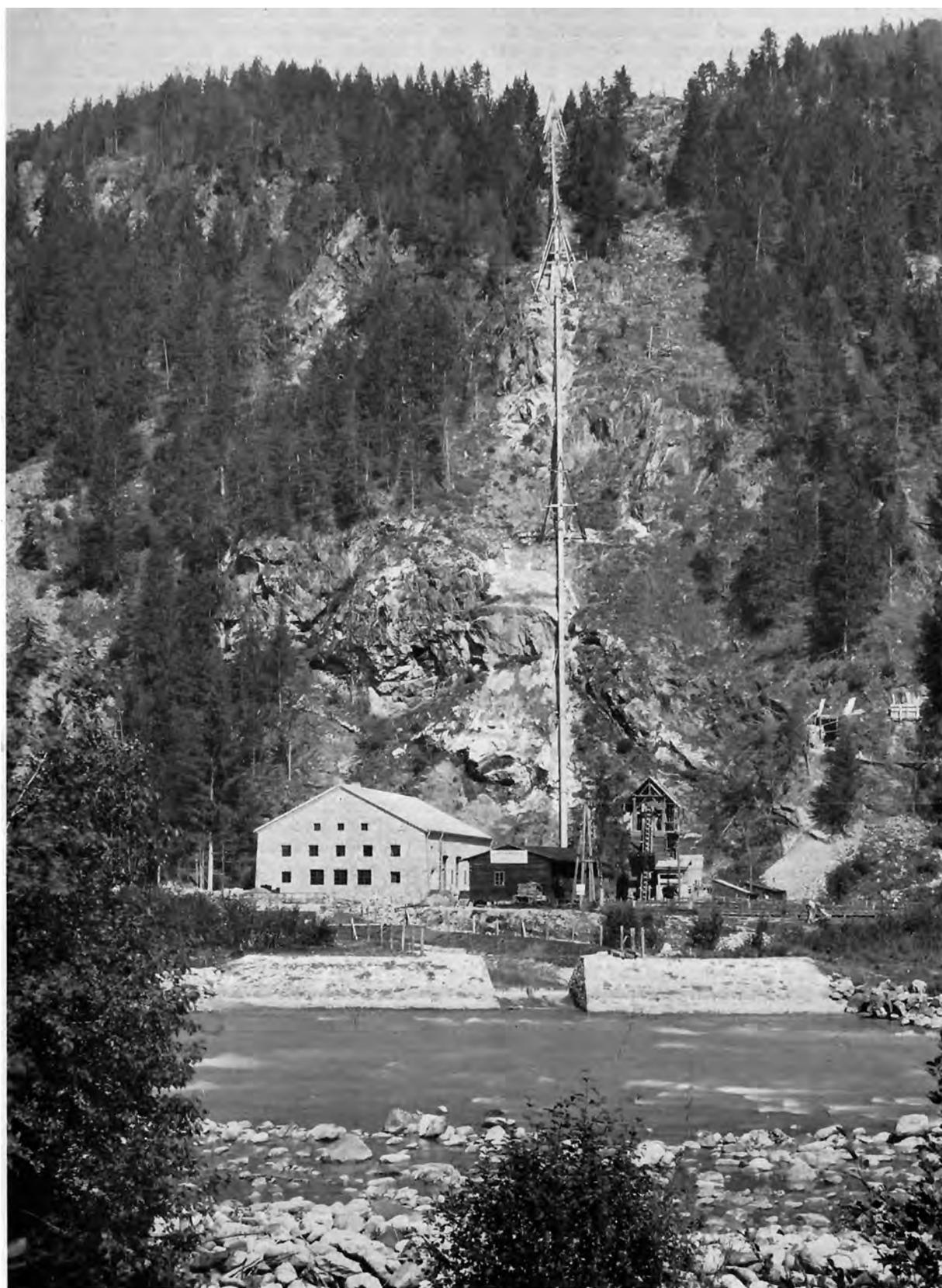
Bild 74: Druckrohrleitung des Kaiserbachkraftwerkes der TIWAG. Vgl. auch Bild 11. Waagner-Biró AG, Wien-Graz
