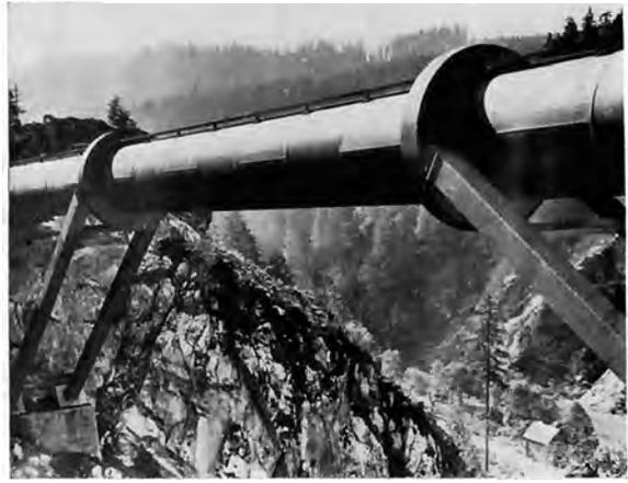
Bild 58: Rohrbrücke der Druckrohrleitung des Salzkraftwerkes. VOEST-Linz
