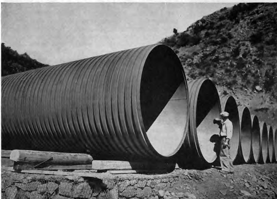
Bild 98: Bandagierte Rohre auf dem Lagerplatz für das Kraftwerk Mucone I der Soc. Meridionale di Elettr., Napoli. Ausführung Soc. TERNI, Terni
