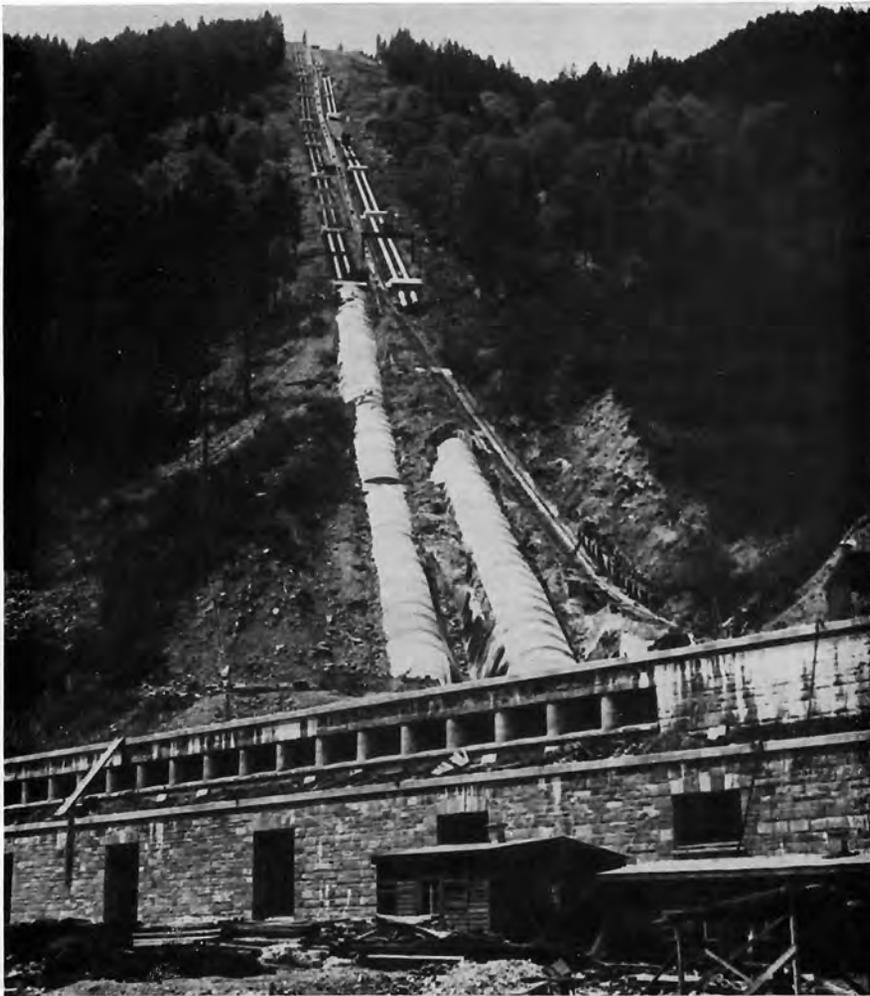
Bild 63: Druckrohrleitung der Hauptstufe Glockner-Kaprun der TKW. Links die beiden Stränge I + II; rechts die beiden Stränge III + IV im Bau. Im Vordergrund das Krafthaus, dahinter der eingedeckte untere Teil der Druckrohrleitungen I + II und III + IV
