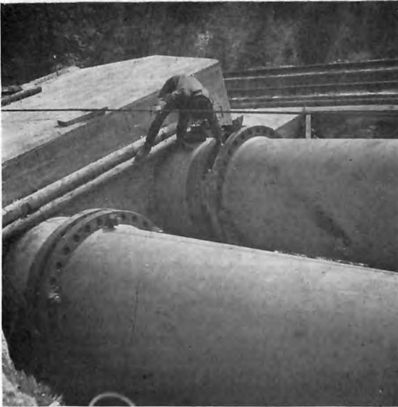
Bild 18: Flanschverbindung mit Keilringpaaren, Montagebild. Druckrohrleitung III und IV der Hauptstufe Glockner-Kaprun der Tauernkraftwerke AG, VOEST-Linz
