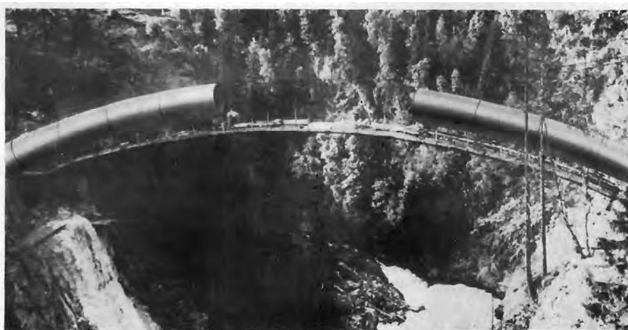
Bild 12: Selbsttragender Rohrbogen mit 72 m Spannweite und 3000 mm  $\phi$ . Kraftwerk Passy-sur-Arve. S. D. E. M., Grenoble. (Über die Berechnung solcher Rohrbogen vgl. R. Bouchayer: „Travaux“, Dez. 1952 und Jänner 1953. M. Esslinger: „L'Ossature Métallique“ 1952. U. Bellometti: Condotte Forzate, Milano 1955)
