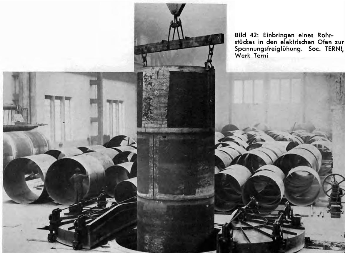
Bild 42: Einbringen eines Rohrstückes in den elektrischen Ofen zur Spannungsfreiglühung. Soc. TERNI, Werk Terni
