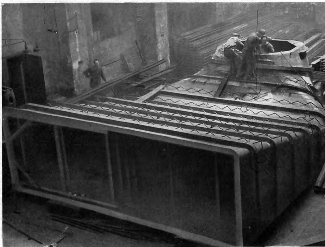
Bild 7: Kraftwerk Ernestina. Saugrohrpanzerung. Maschinenfabrik Andritz AG, Graz
