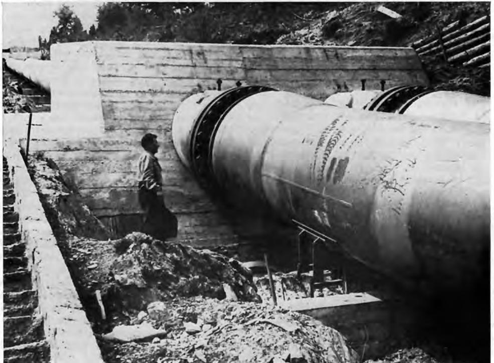
Bild 64: Druckrohrleitung der Hauptstufe Glockner-Kaprun der TKW, mittlerer Teil der Stränge III + IV (Festpunktblock, Mannlochverschlüsse, Stopfbüchsen-Dehnstücke). VOEST-Linz
