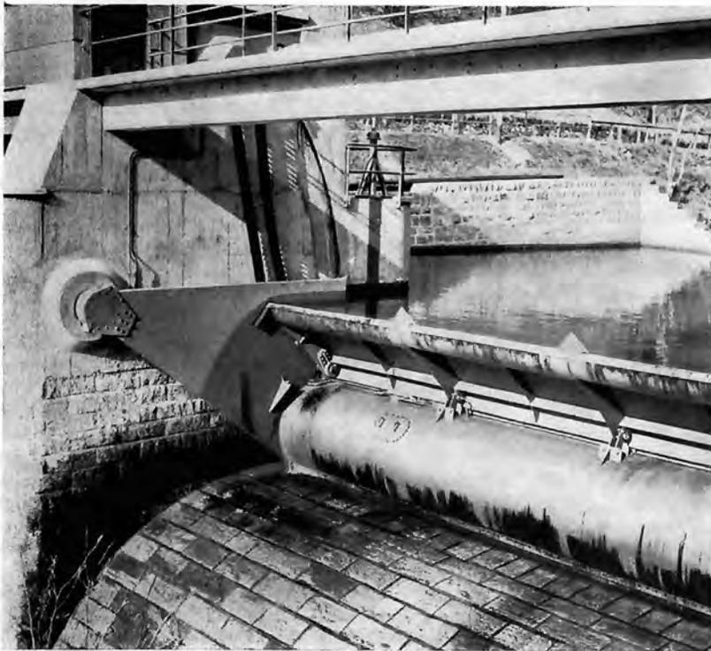
Bild 13: Sektor-Klappenschütze. K.-W. Massagno. Wasserfassung am Cassarate. Automatisch gesteuerte Regulierschütze.
