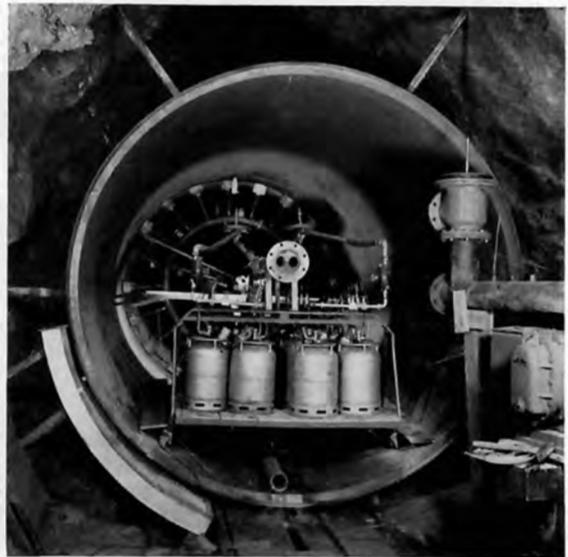
Bild 54: Spannungsfreiglühen der Montage-Rundnaht einer Druckstollen-Panzerung. Mit Butangas geheizter Innenglühofen. Blick auf die Stirnseite des neu angeschlossenen Panzerrohrstückes und auf den koaxialen Spalt zwischen dem Panzerrohr und dem Gebirge; dieser Spalt wird später ausbetoniert und hinterpreßt. Im Vordergrund die Butangasflaschen. Falleitung Fionnay der Anlage Grande Dixence (Walliser Alpen). Gebrüder Sulzer AG, Winterthur
