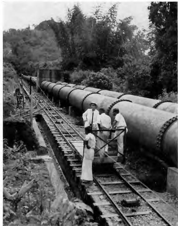
Bild 49: Lichtbogengeschweißte Druckrohrleitung mit genieteten Montagestößen. Anlage Sengulam in Südindien. Dorfmunder Union Brückenbau-AG, Werk Orange, Gelsenkirchen
