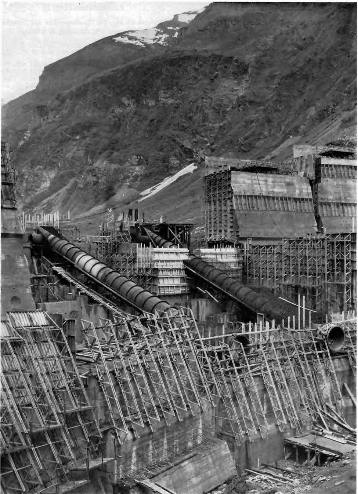
Bild 75: Durchführungsrohre durch den Sperrkörper Limberg, Turbinenauslauf- und Pumpeneinlaufrohre der Oberstufe Glockner-Kaprun der TKW. Waagner-Biró AG, Wien-Graz. Im Vordergrund die Stahlschalungen für die Mauerblöcke der Gewölbemauer Limberg
