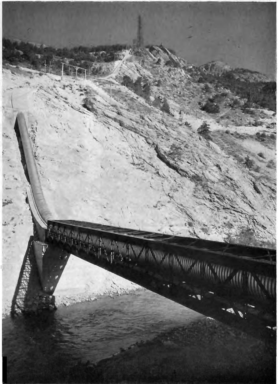
Bild 14: Krümmer einer freien Druckrohrleitung, ohne Betonhaube im Festpunktblock verankert. Druckrohrleitung Riddes der Anlage Mauvoisin, Walliser Alpen, Schweiz. Gebrüder Sulzer AG, Winterthur
