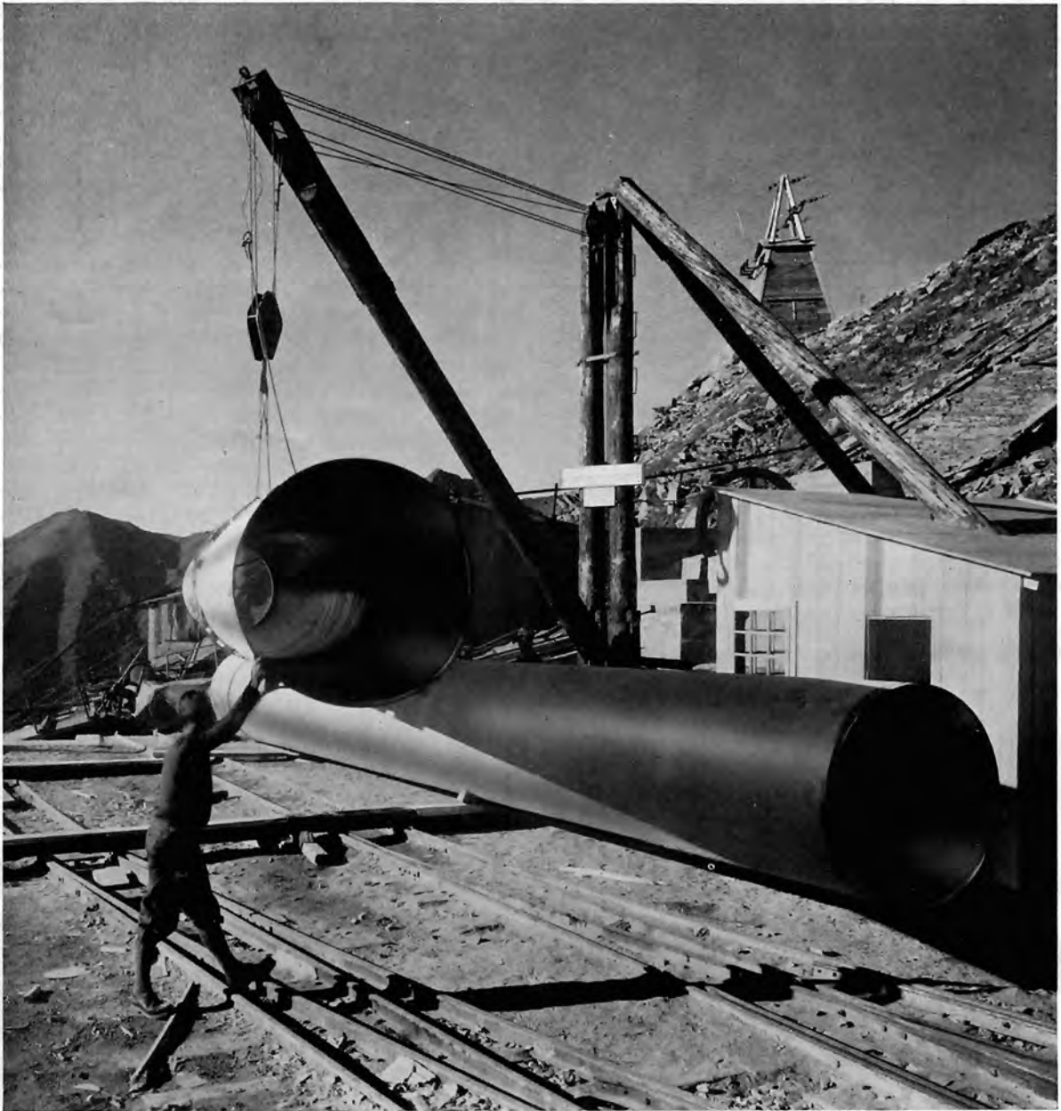
Stollenrohre zum Einbau am Schoberboden (Draukraftwerk Reifheck).
