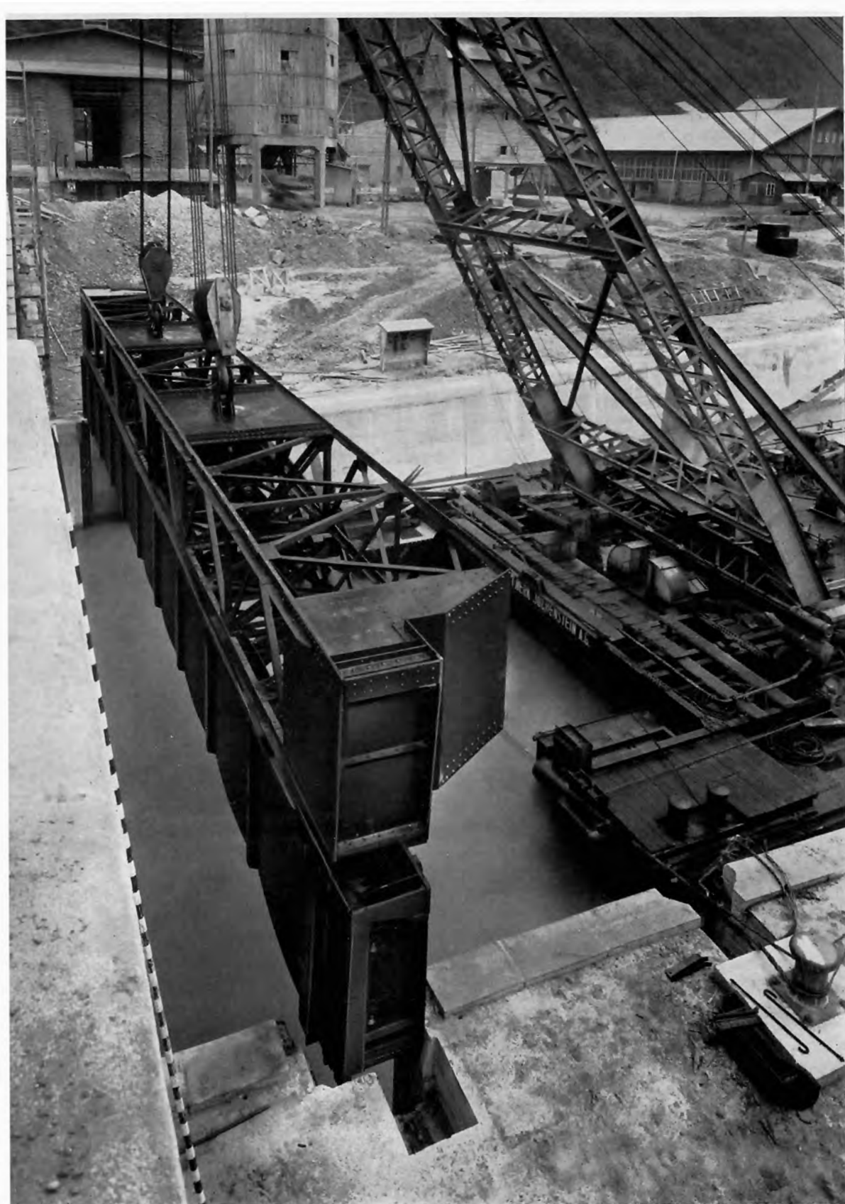
Einsetzen der Dammtafeln beim Donaukraftwerk Jochenstein.
