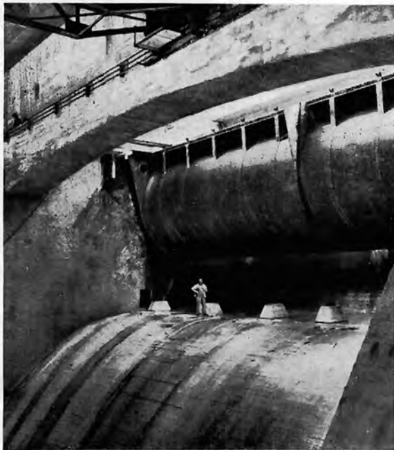
Stauklappe des Kraftwerkes Großraming Verschlußweite 23,70 m, Verschlußhöhe 5,50 m Flap gate of power plant Grossraming closing width 23,70 m, damming head 5,50 m
