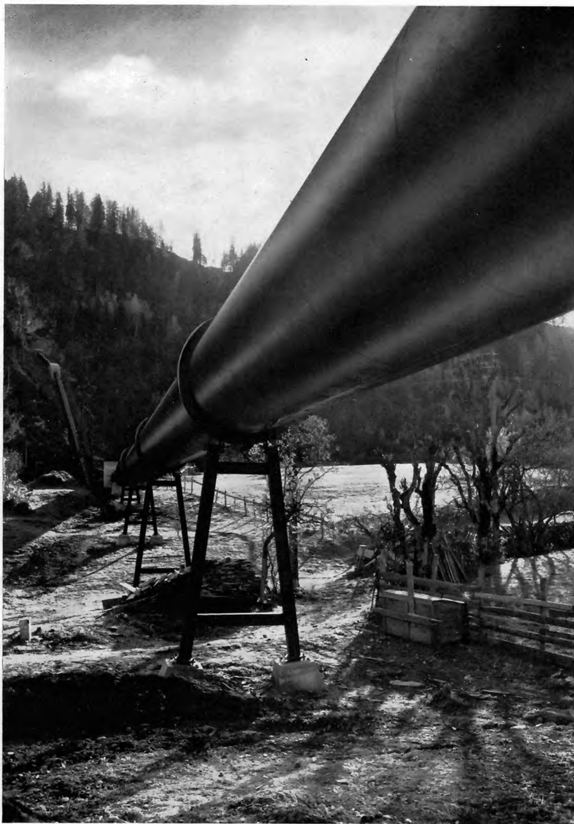
Turbinenrohrleitung für das Kraftwerk Rauris-Kitzloch. Durchmesser 1800/1500 mm, Länge der Rohrleitung 750 m, Gefälle 250 m. Gesamte Rohrleitung elektrisch geschweißt.
