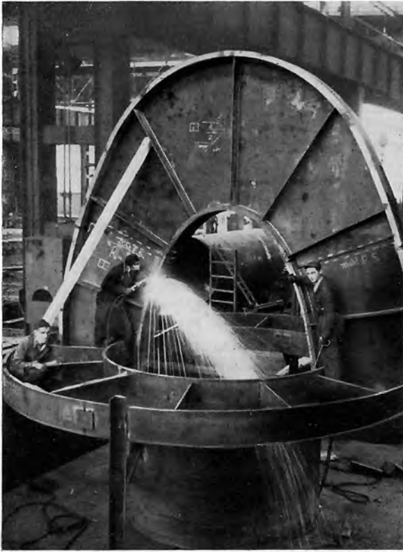
Geschweißter Nahlträger eines Hosenrohres im Zusammenbau, 2500/2 × 1700 mm Durchmesser, Gefälle 465 m.
