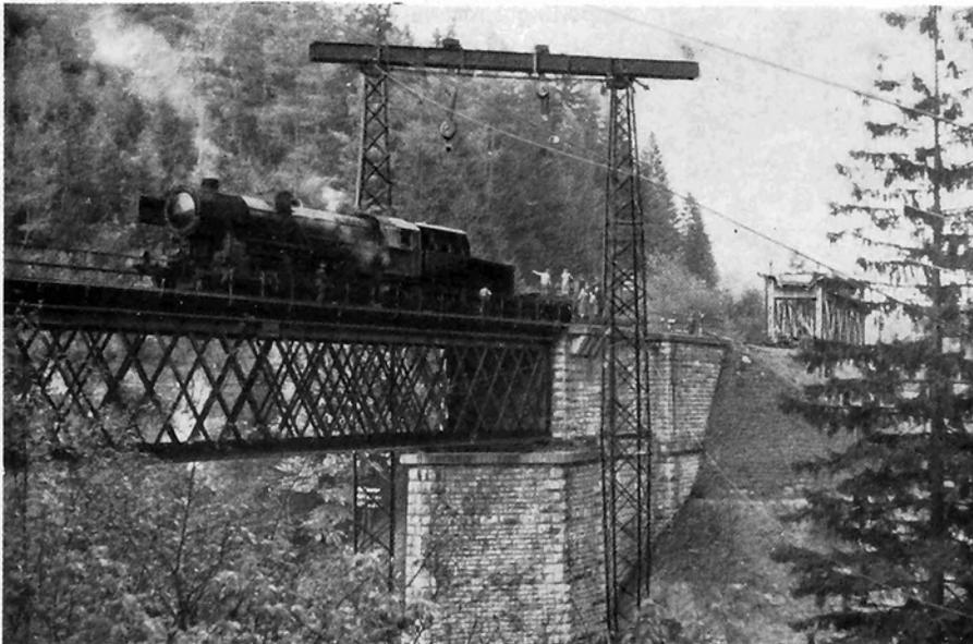
Bild 5. Das neue Tragwerk kurz vor der Einbaustelle
