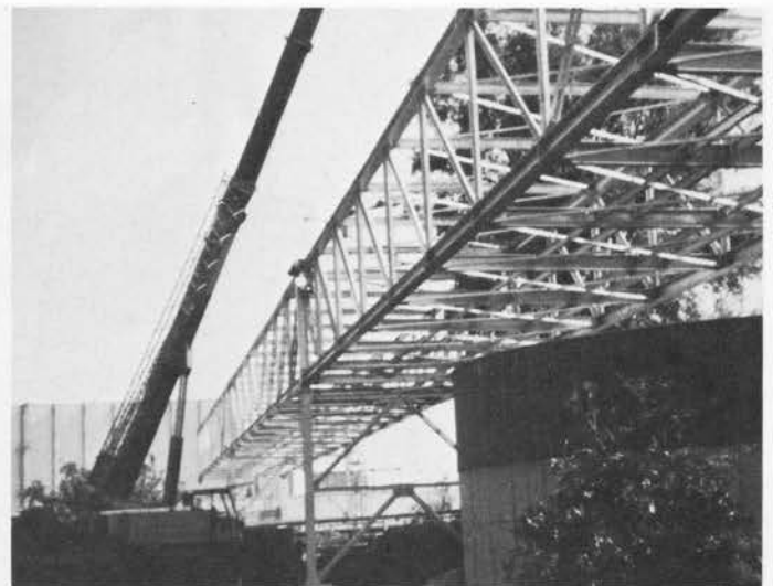
Stahlskelett Brücke XR
