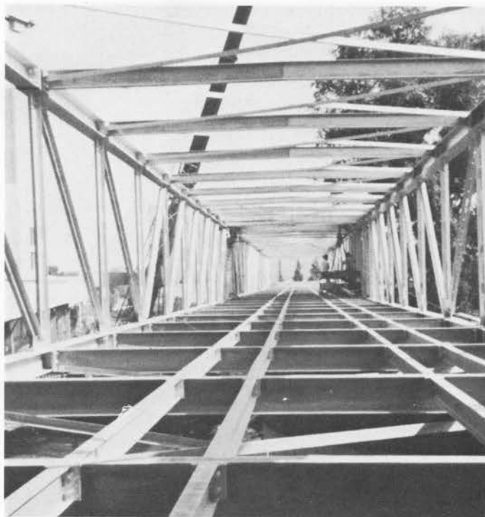
Brücke XR, Innenansicht
