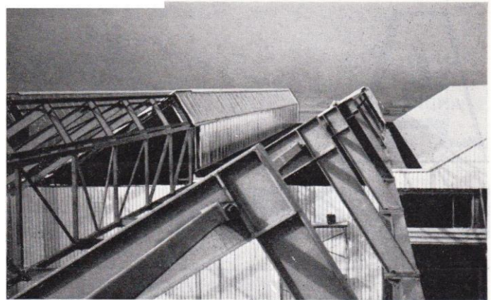
Schnitt durch die Tragkonstruktion des Bürotraktes und der Halle sowie durch die Deckung am Übergang Büro trakt zur Halle .
