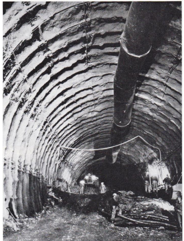
... und beim Bau des Tauernautobahn.Scheiteltunnels.
