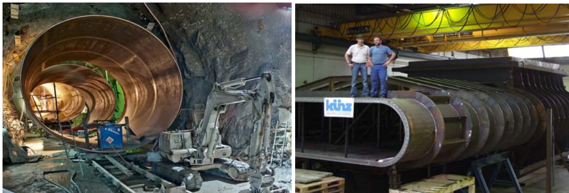
Abbildung 2 Typische Stahlwasserbauteile am Beispiel des Pumpspeicherkraftwerkes Limberg 2
