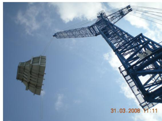
[5] Einhub der Windkanaldüse mit dem schienengeführten Turmdrehkran
