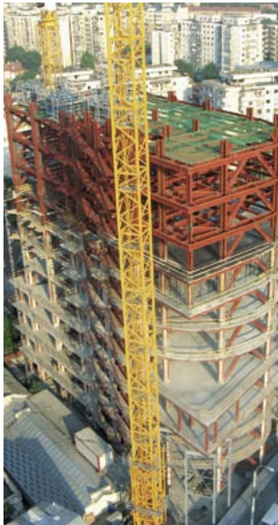
Bucharest Tower Center (BTC): 4.500 t Stahl in geschraubter Ausführung ein – 26-stöckiges, 120 m hohes Projekt mit einer Bürofläche von 20.800 m 2
