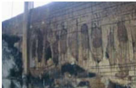
Abgeplatzter Beton in den Boxen
