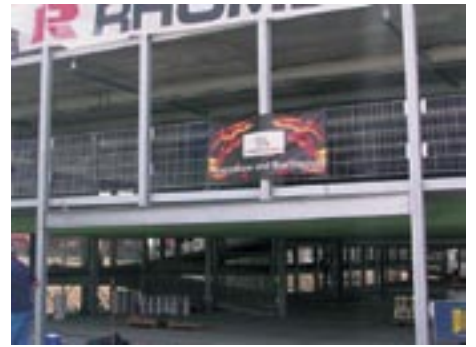
Brandschutz von Christ Lacke, etwa an einem Parkdeck in Graz
