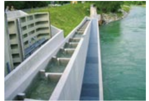
Fischaufstieg und Dammbalkenanlage
