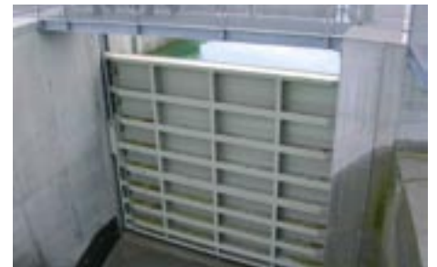
Hydraulisch betriebenes Kiesgassenschütz
