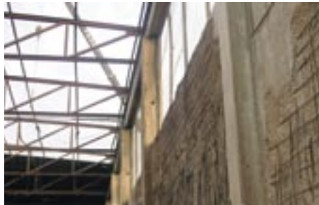
Stahlbau nach Demontage von Trapezblech
