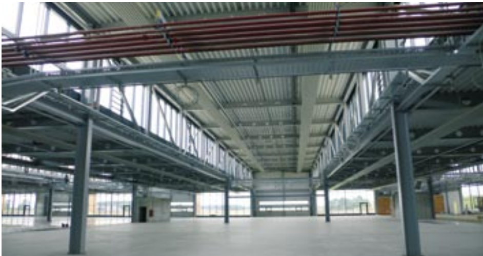
Fronius in Saitfeld: Die Montagedauer von nur acht Wochen für den gesamten Stahlbau war äußerst knapp bemessen
