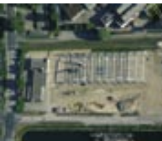
Bild 4: Vogelperspektive Produktionshalle, Baufortschritt in der 2. Montagewoche
