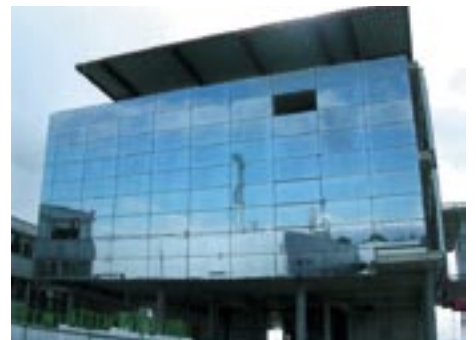
Ebenfalls brandgeschützt mit Dämmschichtbildner
