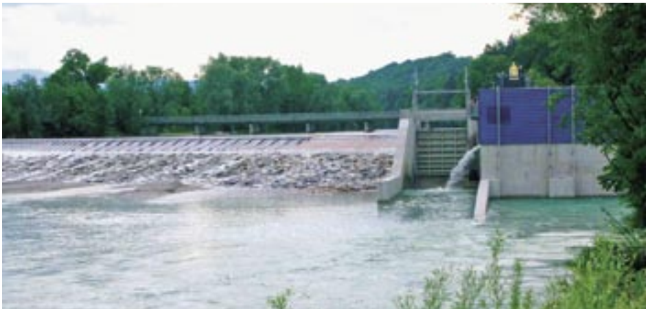
Wehranlage mit Krafthaus und Kiesgassenschütz
