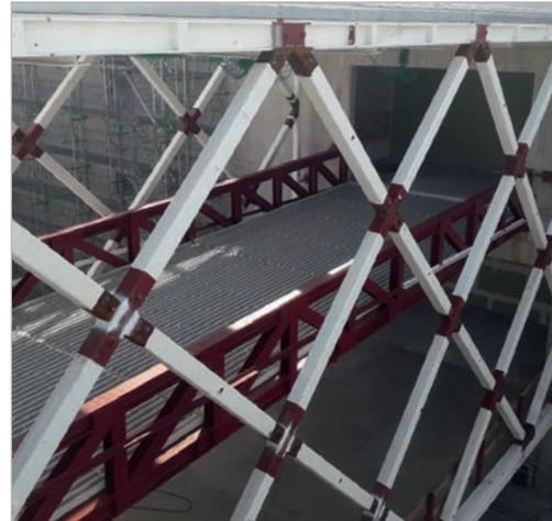
Bauzustand der Fachwerke, Bauteile R90 werksbeschichtet.
