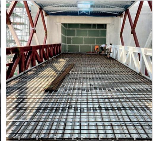
Stützenfrei: Verbundbleche als Schalung und Bewehrung. Keine zusätzliche Schalung oder Deckenstützen nötig.
