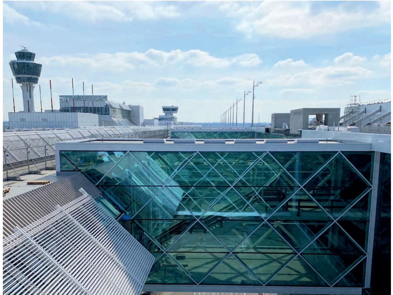
**Stahlkonstruktion:** 370 Tonnen, 4.600 m<sup>2</sup> R90 Beschichtung,
