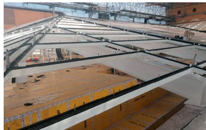
Neue Stahlkonstruktion und Basisdichtungen montiert
