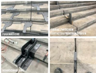
WELLENBRECHER: NAHEZU UNSICHTBARE ABER HOCHBELASTBARE VERANKERUNG DER WELLENBRECHER IN DIE TIEFERLIEGENDEN TRIBÜNENTRÄGER
