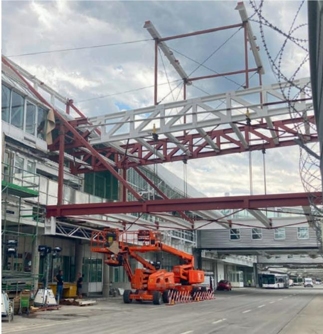
Ressourcenschonend: Minimale Zusatzkonstruktion für die stützenfreie Montage unter Berücksichtigung und Einhaltung der Werkstattform und unter Zuhilfenahme der Konstruktion selbst. Frei bleibende Betriebsstraße des Flughafens.
