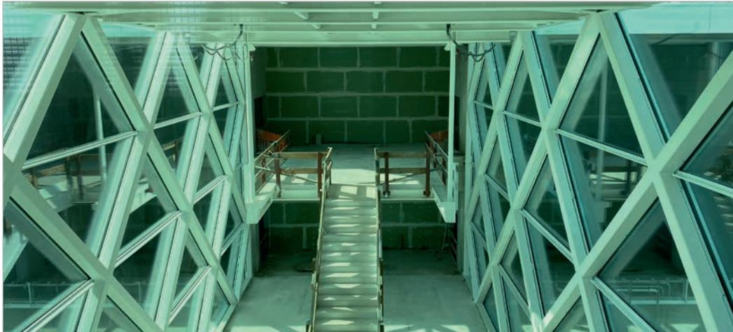
Für die vorgesetzte Glasfassade mussten im Werk 144 Stück Anschlussdrehteile, unter Einhaltung eines minimalen Toleranzbereichs von +/-1 cm, deutlich abweichend von den zulässigen Normtoleranzen, passgenau angeschweißt werden.
