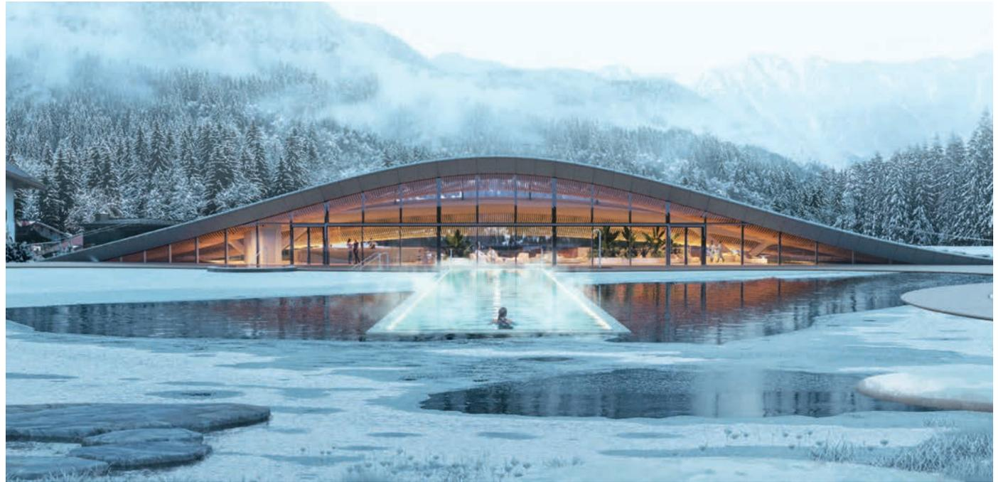
Mit „Atmosphäre by Krallerhof“ ist eine neue und innovative Spa- und Wellnessanlage entstanden, die sich harmonisch in die umliegende Berglandschaft des Leoganger Tals integriert. Große Teile der Westfassade können über eine Distanz von 22 Metern nahtlos im Boden versenkt werden und lassen Innen- und Außenraum verschmelzen.
