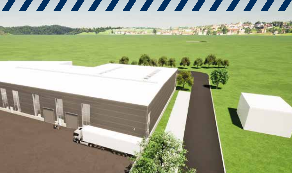
Die neue Halle in Stahlkonstruktion wird nahezu zwischenstützenfrei errichtet.
