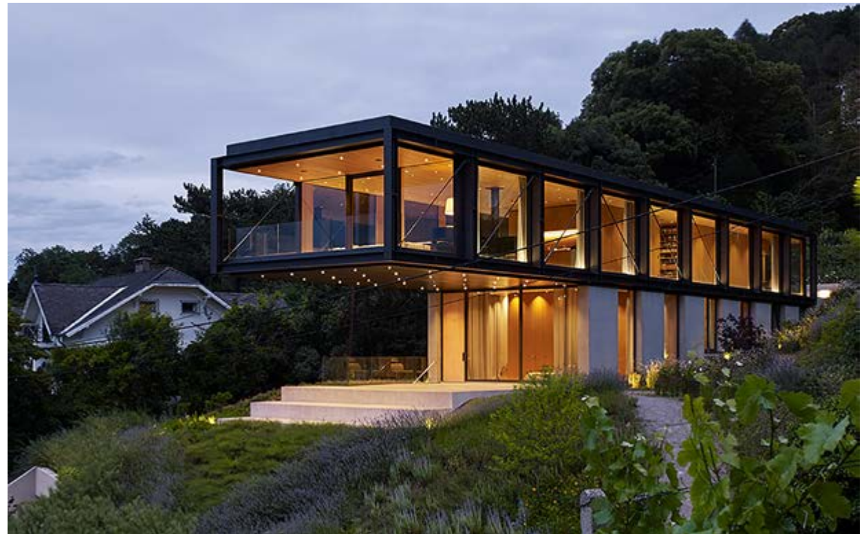
Die eindrucksvolle, allseitig verglaste 36 Meter lange Stahlkonstruktion macht sich die schwierige Hanglage zu Nutzen: Ansicht Nordwest
