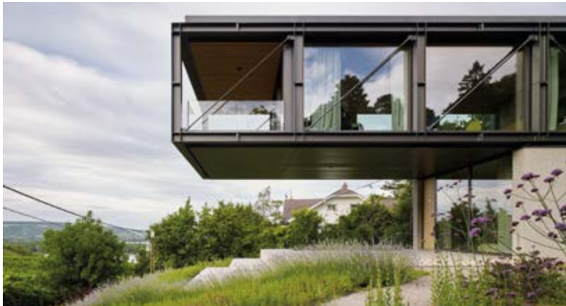
Der Riegel mit außenliegendem Stahltragwerk schwebt 12 Meter frei ausragend auf dem massiven Sockel: Ansicht West
