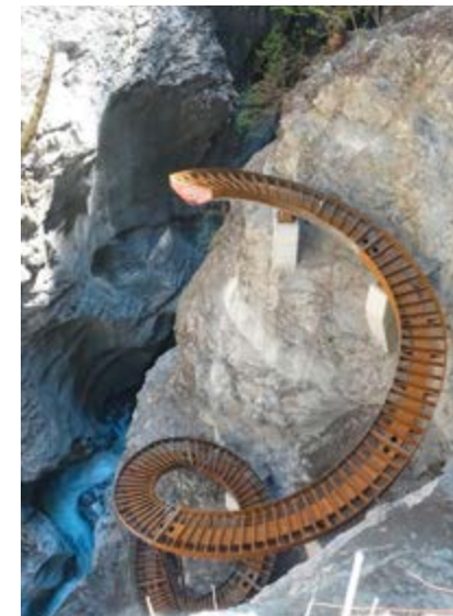
MONTAGE: vorgefertigte Elemente nr.4 - nr.7 (Montagestützen unterer Bereich)
