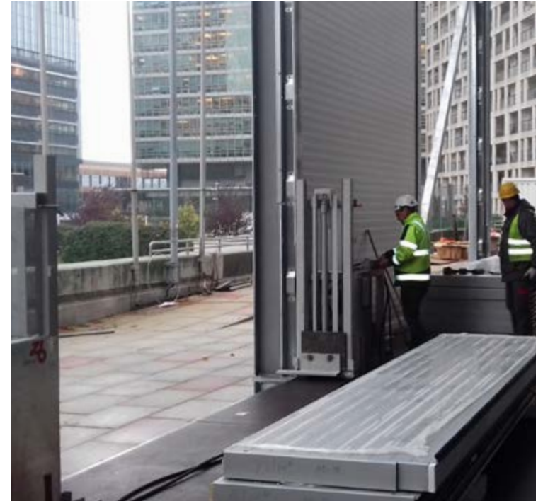
Parallel zum Bau wurde eigens eine Systemwand inklusive Hebemechanismus entwickelt. Die Halle kann so innerhalb von zwei Wochen geschlossen werden.
