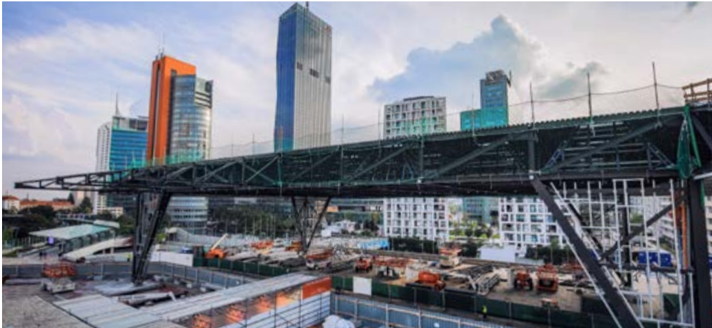
Aufgrund der existierenden Dehnfugen und limitierter Belastbarkeit des Platzes waren Fundamentierung, Lastabtragung sowie Logistik und Montage Schlüsselfaktoren.
