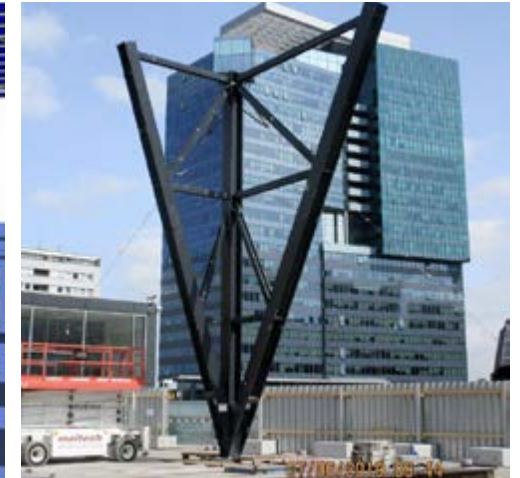
Ein 60x60 cm schlanker Stahlkasten durchdringt die Decke des obersten Parkdecks.
