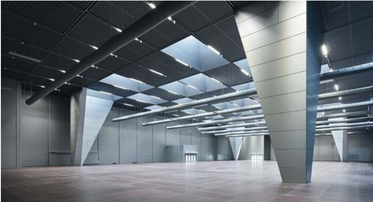
Durch die geschlossene Halle stehen dem ACV zusätzliche 4.300 m 2 unterteilbare, beheizte Ausstellungsflächen zur Verfügung. 120 Abhangpunkte an der Decke können zeitgleich jeweils mit bis zu einer Tonne belastet werden. Foto: Bruno Klomfar für Dietrich | Untertrifaller
