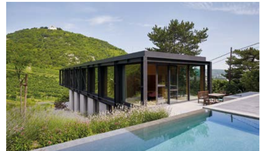
Auf der Rückseite liegt der terrassenförmig angelegte Garten mit Pool: Ansicht Süd
