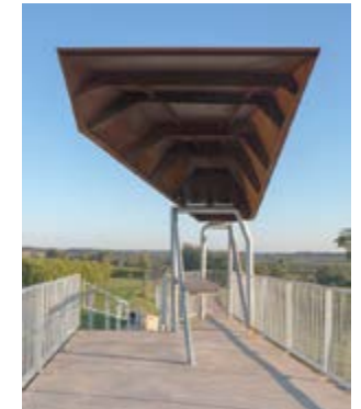
Untersicht der „Plated Structure“
