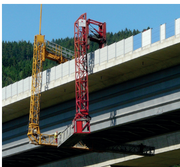
Zustandsüberprüfung einer Autobahnbrücke mit Brückenprüfwagen © MCE GmbH
