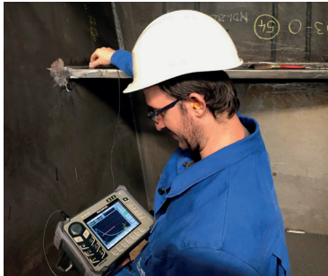
Umfangreiche Ultraschallprüfung der Schweißnähte während der Produktion © MCE GmbH
