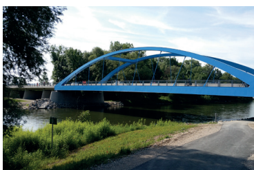
Straßenbrücke über die Isar bei Moosburg, Deutschland © Haslinger Stahlbau GmbH
