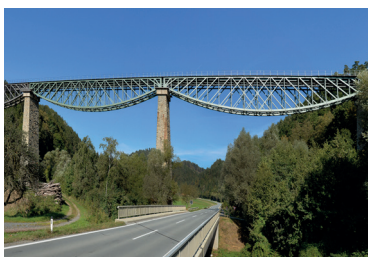
Historische Eisenbahnbrücke über die Lafnitz, bei Rohrbach © ÖBB Infrastruktur Robert Deopito
