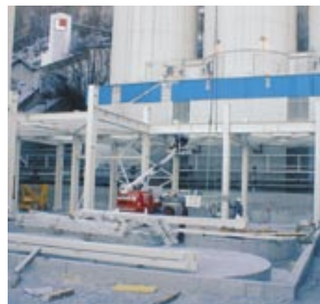
Erster Montageabschnitt der Omya-Halle in Golling
