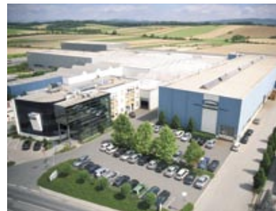
Unternehmenszentrale Unger Stahlbau Oberwart
