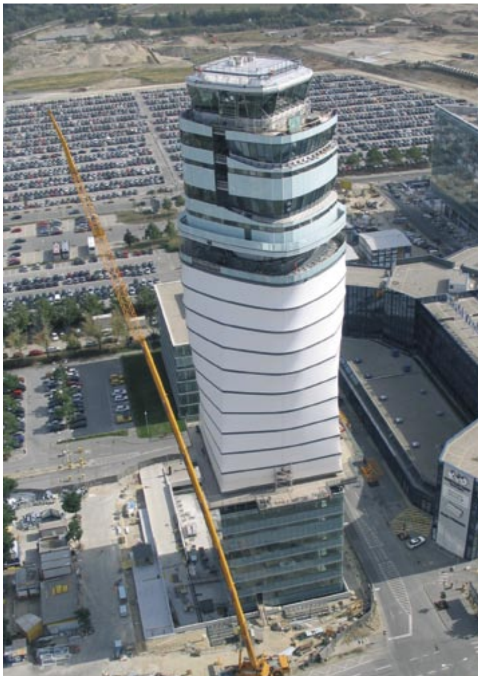
„Landmark“ am Flughafen Wien Schwechat: Der neue Tower
