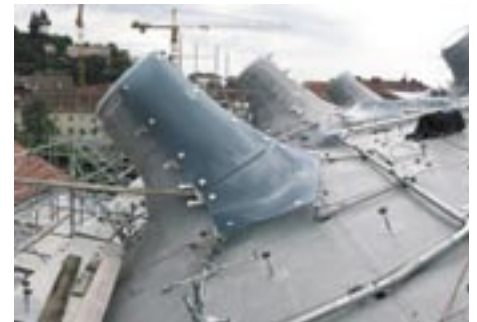
Bild 5: Dachlandschaft während der Montage, ARGE Kunsthaus
