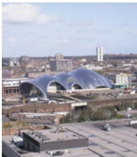
Bild 5: Südseite des Gebäudes mit den 3 Randbögen zwischen den Widerlagern
