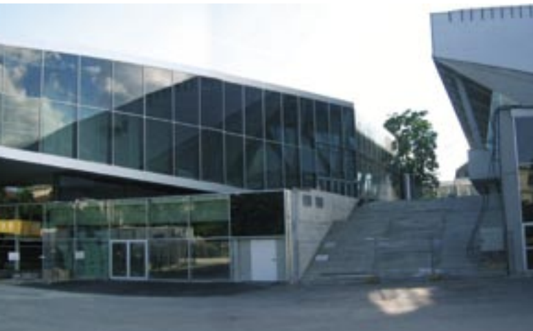
der neuen Halle F sorgt für Fernwirkung zum Gürtel
