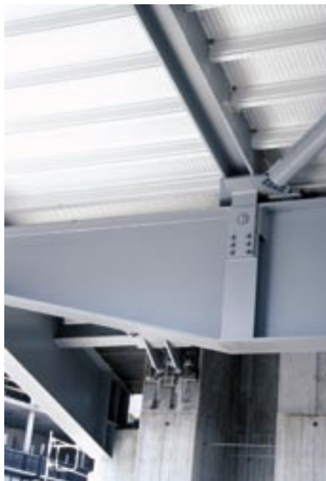
Anschluss Querträger und Verband
