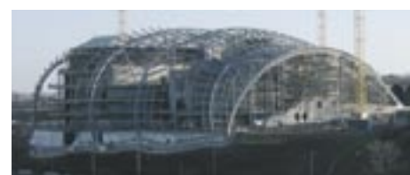
Bild 4: Stahlkonstruktion während der Bauphase Januar 2003
