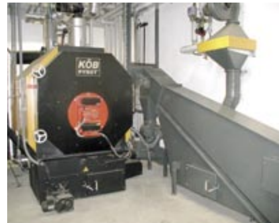
Anlage Bildstein: PYROT mit Vortrockner
