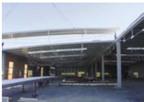
Domico: Aufstellen der Hallenelemente – Stützen im Hallenbereich konnten entfallen
