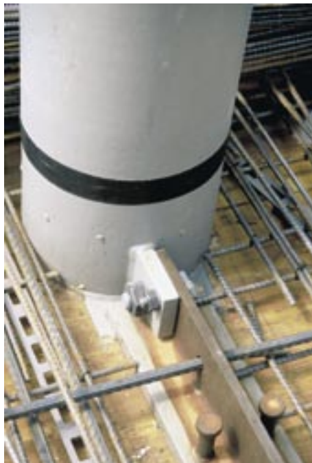
Anschluss Slimfloorträger an Randstütze
