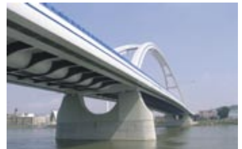
Bild 7: Brücke in Endlage
