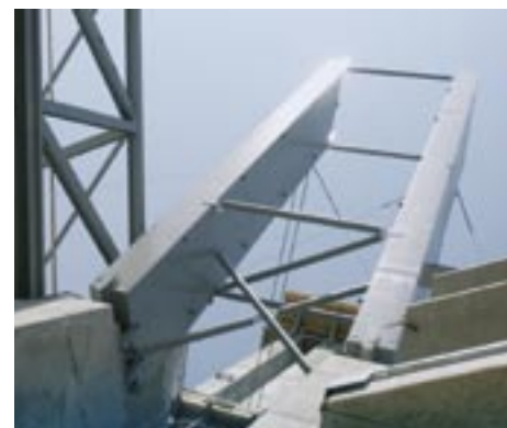
Montage der schrägen Stützen
