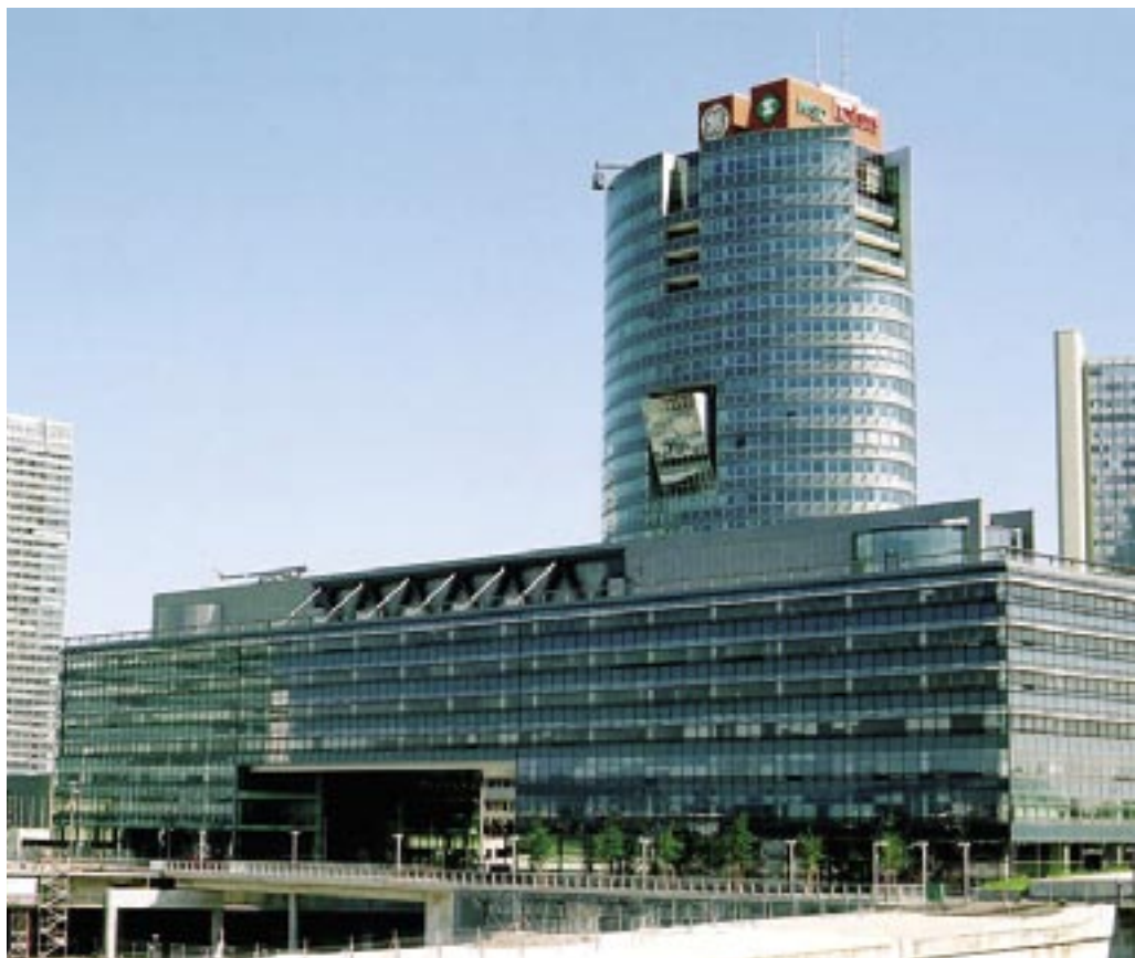
Sichtbare und formgebende Tragstruktur mit Stahl – am Tech Gate in Wien
