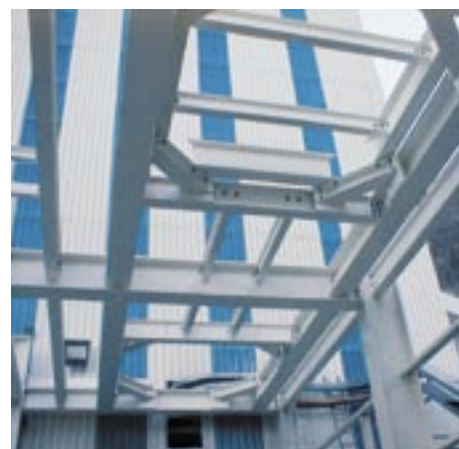
Erster Montageabschnitt und Blick auf die PCC-Anlage
