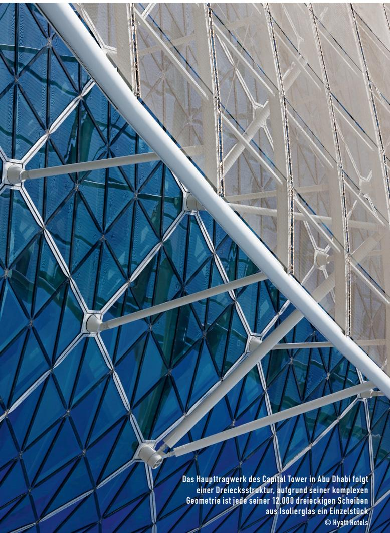
Das Haupttragwerk des Capital Tower in Abu Dhabi folgt einer Dreiecksstruktur, aufgrund seiner komplexen Geometrie ist jede seiner 12.000 dreieckigen Scheiben aus Isolierglas ein Einzelstück
