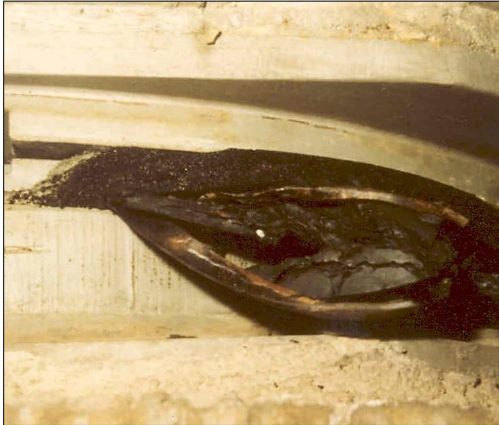
🏠 Austreten des Elastomerkissens durch Versagen der Dichtung und durch zu hohe Auflast
