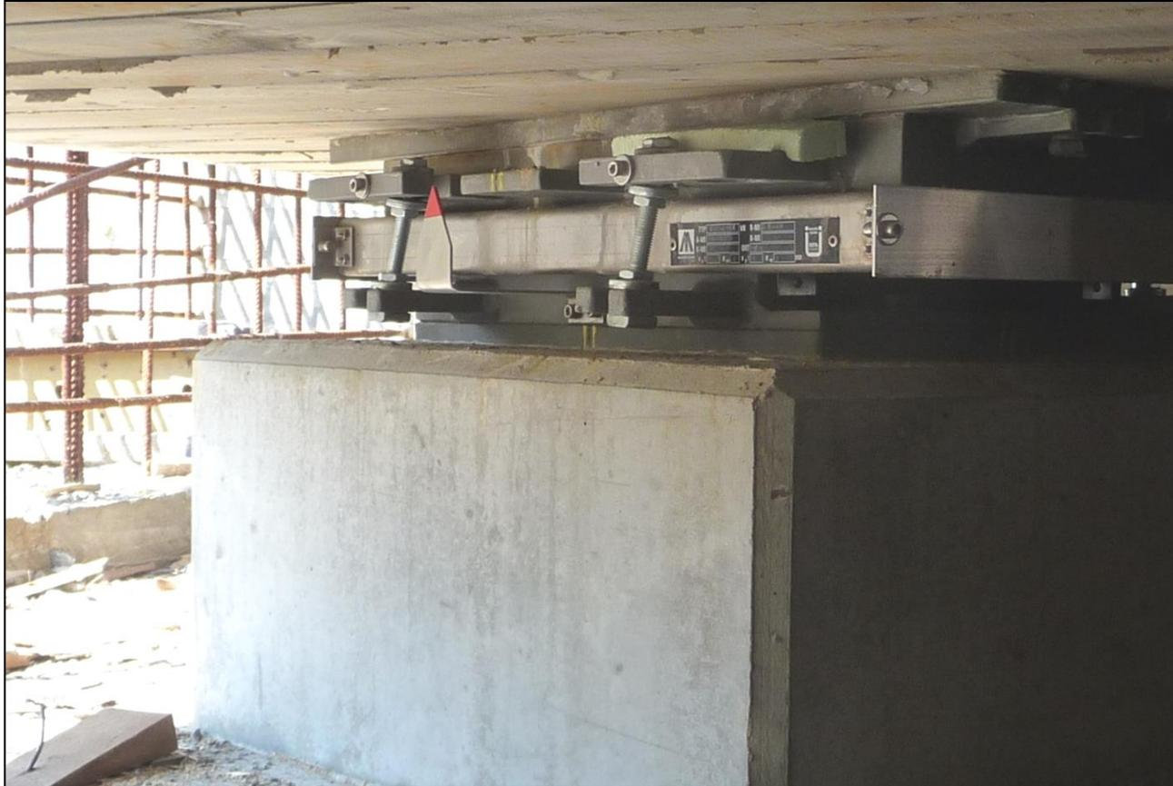
🏠 Lösen der Arretierungen nach vollständigem Lagereinbau nicht durchgeführt!
