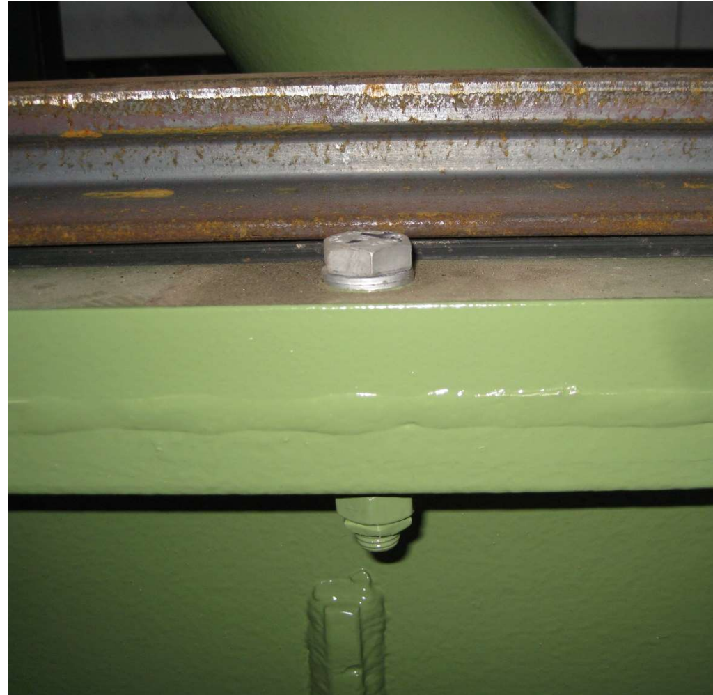
Fertige Installation mit neuer Schiene und Korrosionsschutz
