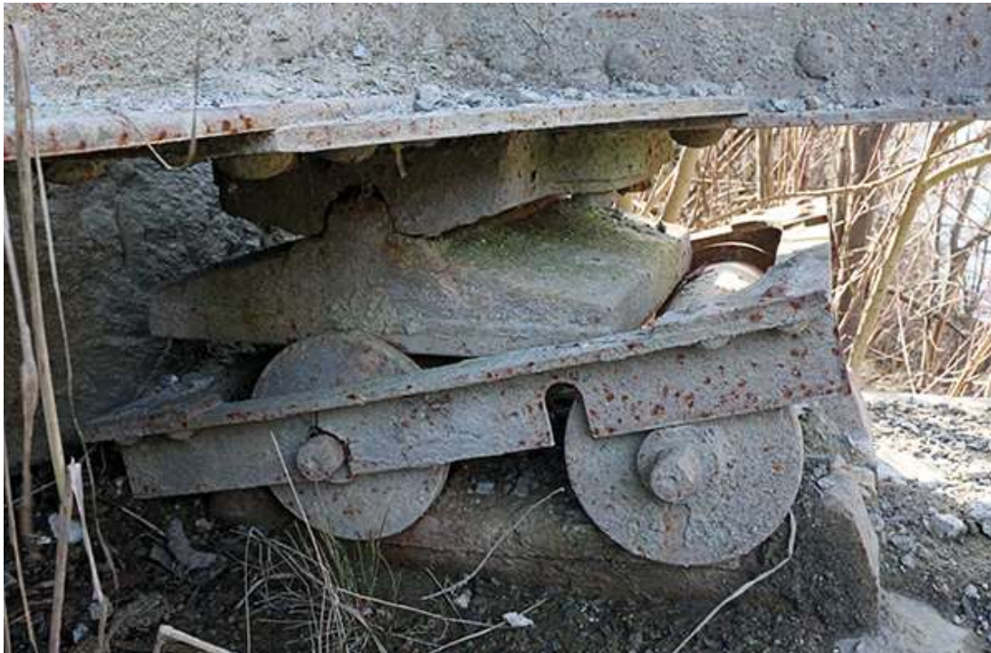
Brückenlager defekt
