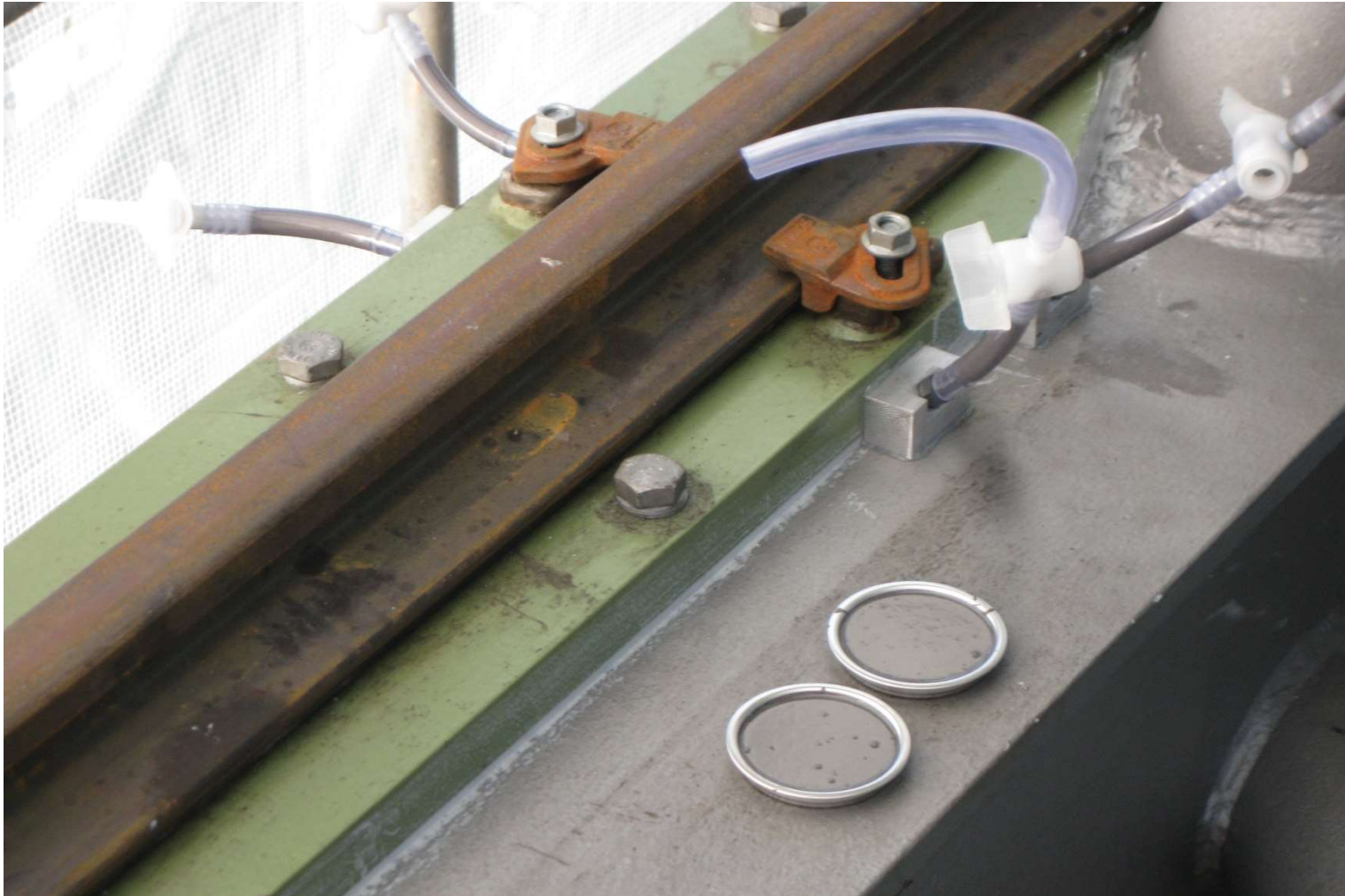
Injektion abgeschlossen – Rückmusterdeckel für Qualitätssicherung
