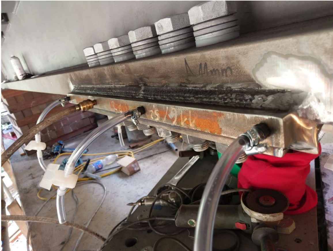
Setzen der Injektionsanschlüsse
