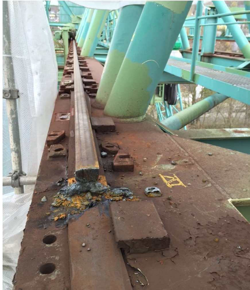
Abbau der alten Fahrschienen
