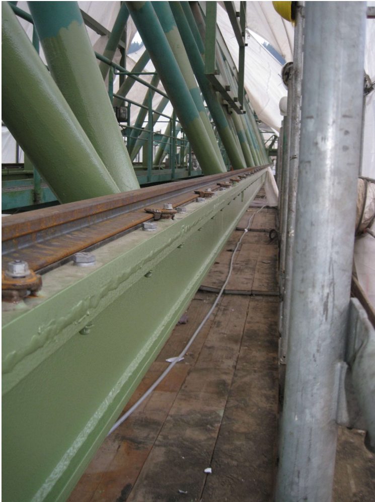
Fertige Installation mit neuer Schiene und Korrosionsschutz
