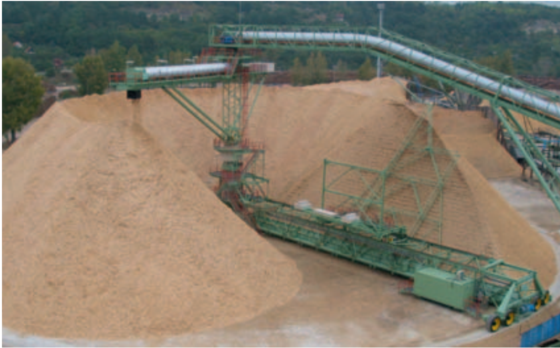
Reclaimer, mit Stacker auf Centre Column und der darüberliegenden Förderbandbrücke
