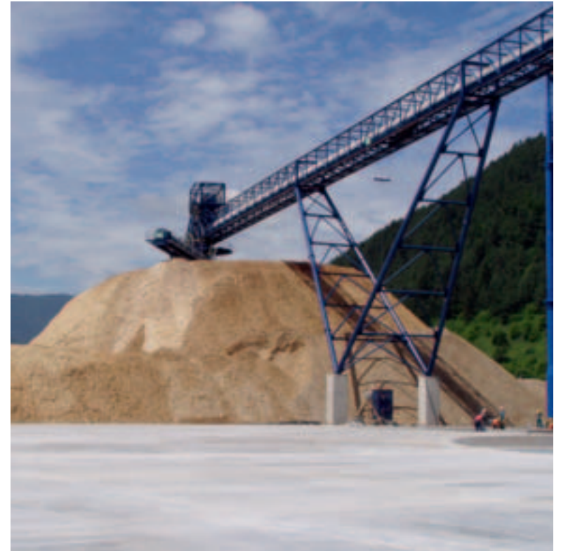
Förderbandbrücke mit schiefen Stützen
