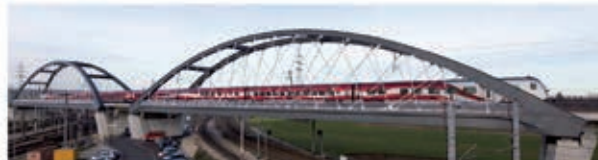
STAHLBAUPREIS 2013 – 3. PLATZ – VERBINDUNG OSTBAHN – FLUGHAFENSCHNELLBAHN – BILFINGER MCE GMBH
