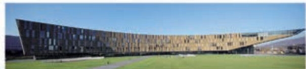
STAHLBAUPREIS 2011 – 3. PLATZ – VERKAUFS- UND FINANZ- ZENTRALE DER VOESTALPINE STAHL GMBH – ZEMAN & CO
