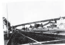
Bild 1. Ansicht der Hochstrasse
