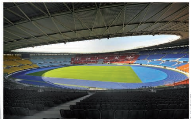
EUROPEAN STEEL DESIGN AWARD 1989 – PRATERSTADION TRIBÜNNENÜBERDACHUNG – VOEST-ALPINE AG
