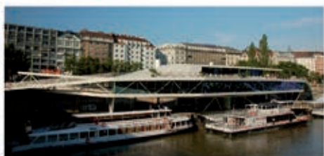
3. STAHLBAUPREIS 2011 – SIEGERPROJEKT NEUE ANLEGESTELLE TWIN CITY LINER WERKRAUM WIEN & UNGER STAHLBAU
