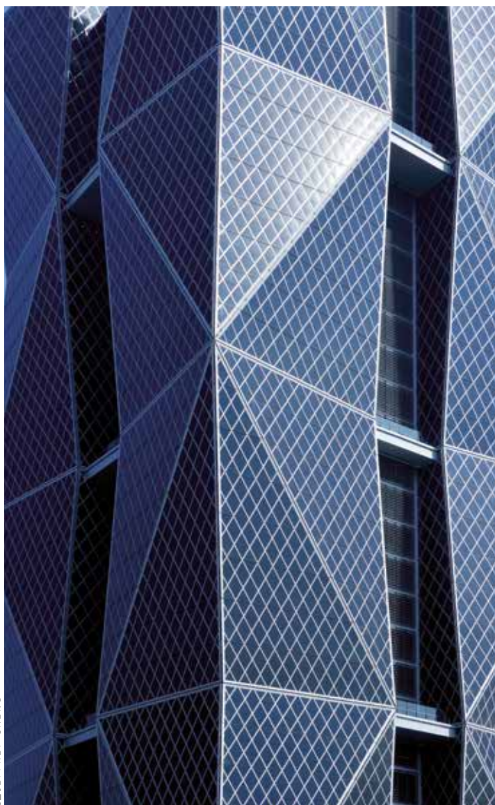
Stahl für Stahl, China Steel-Gebäude, Kaohsiung/Taiwan.
